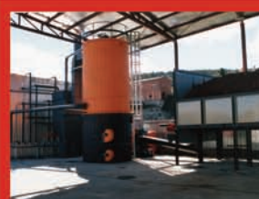
Calderas de biomasa con alimentación automática
