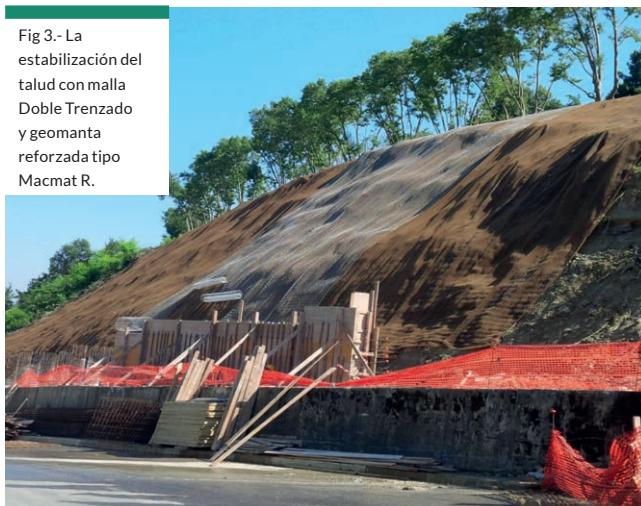
Fig 3.- La estabilización del talud con malla Doble Trenzado y geomanta reforzada tipo Macmat R.
