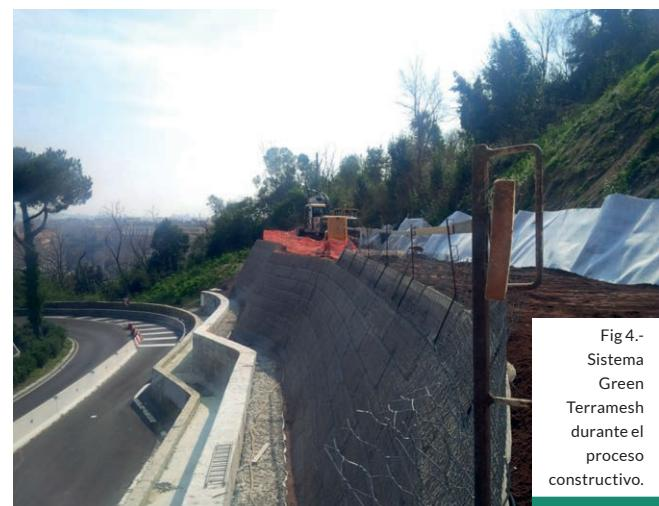
Fig 4.- Sistema Green Terramesh durante el proceso constructivo.
