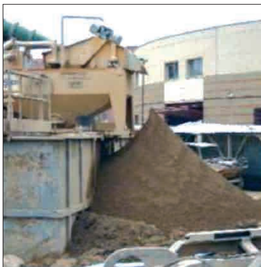
■ [Fig. 2].- Desarenador mecánico.
