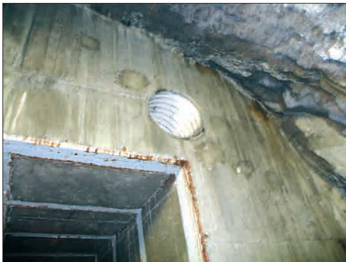
[Figura 7]. - Cierre de galería en la Galería de Ipalán en La Gomera.
