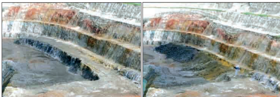
[Figura 3].- Aspecto de una voladura de contorno en mineral situada en la zona Este de la corta de Las Cruces. El talud situado por encima de la voladura tiene 150 m, 20 m en roca paleozoica y 130 m en margas del Terciario. Fotos: cortesía de CLC.
