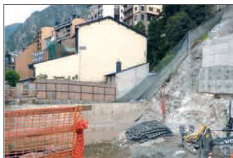
Detalle de la obra de Tobira y lateral muy cercano a otras edificaciones.
