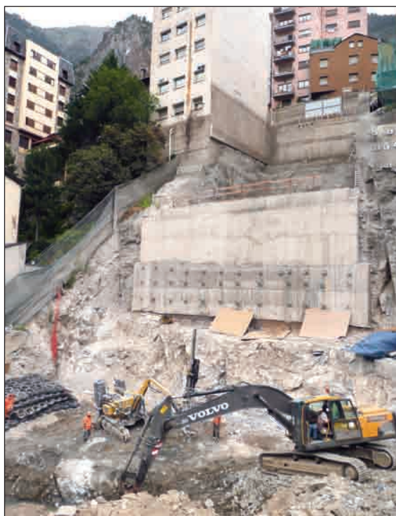
[Figura 5].- Imágenes de la obra de Tobira y su emplazamiento a pocos metros de edificios residenciales y de servicios.
