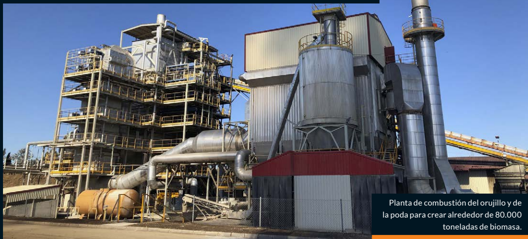
Los secaderos de la planta de Puente Genil tienen capacidad de secar 400 toneladas, aunque en estos momentos trabajan sobre las 250.
