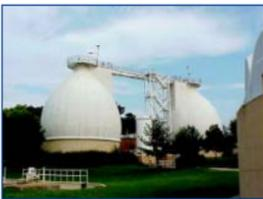
El Metano se produce dentro de los digestores en un proceso de varias fases: Hidrólisis. Acidogénesis, Acetogénesis y Metanogénesis y en el que intervienen varios grupos de microorganismos con sus peculiaridades y puntos de trabajo idóneos.
