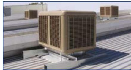
conservación de las mercancías que sufren con el calor excesivo. Además el gran caudal de aire filtrado y lavado que introducimos en las naves permite arrastrar hacia las puertas y ventanas abiertas toda clase de humos, olores, gases de soldadura, etc..., por lo que son adecuados para talleres y exposiciones de automóviles, imprentas, lavanderías, tractilado de plásticos y en general todo tipo de industrias.
