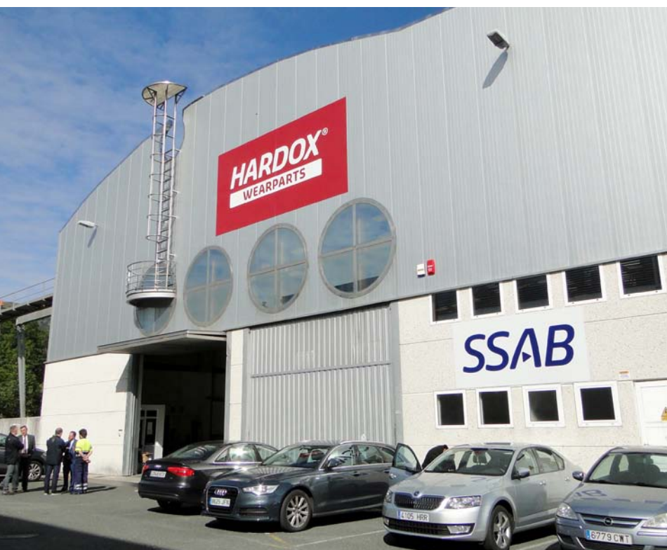
Fachada del nuevo Hardox Wearparts Center de Donosti (Polígono Industrial Oizabaleta, en Irún).
