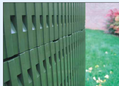
Sistema de aireación mediante agujeros en las paredes
