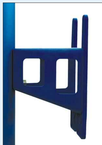
Detalle del anclaje entre las papeleras y el poste
