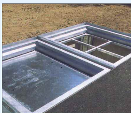
Chapa móvil para inspección o limpieza de la fosa
