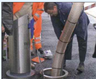
Detalle de vaciado por aspiración
