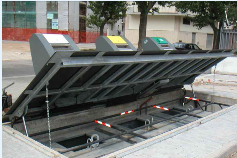
Detalle de apertura de la plataforma basculante para extracción/introducción de los contenedores
