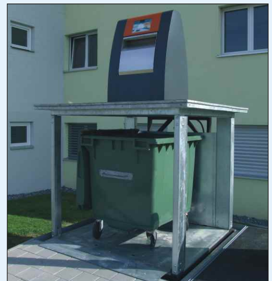
Elevación de la plataforma para extraer el contenedor
