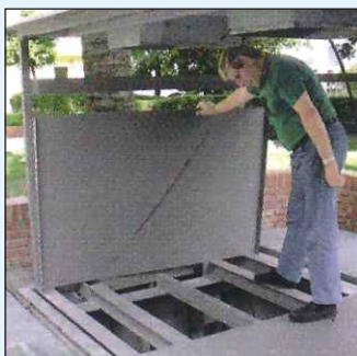
Plataforma metálica móvil que permite el acceso al foso
