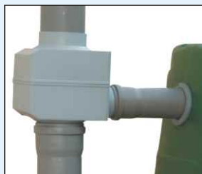
Detalle de instalación: canal, filtro y cuba
