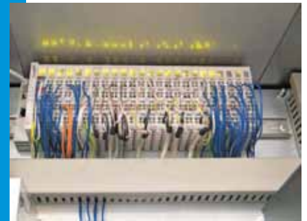
I/O – terminales bus (Fieldbus EtherCAT)
