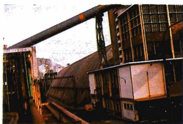
Recubrimiento anticorrosivo HYDROPLAST de estructuras metálicas y conducciones para ácidos.
