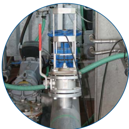
Fig. 3: SOLITAX highline sc en tubería
