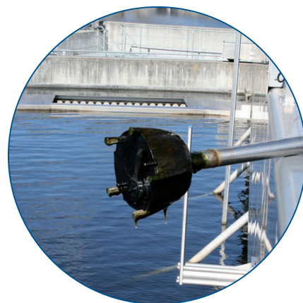
Fig. 5: SONATAX sc en posición de mantenimiento
