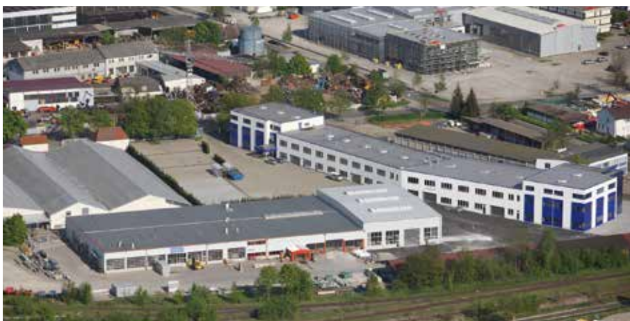
Fábrica Christ 2 para la producción de equipos de lavado de vehículos industriales
