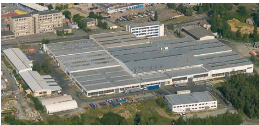
Fábrica de producción en Pilsen, con 29.082 m 2 de superficie construida.
