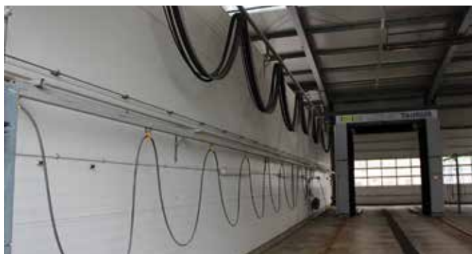
Perfil C para alta presión manual, así como equipo de conducción de suministro
