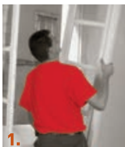
1. Desmontaje de las hojas
