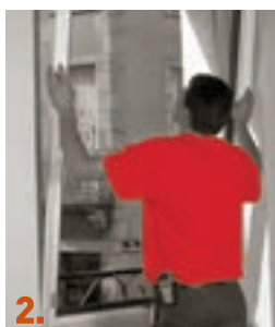
2. Aplicación de la nueva carpintería
