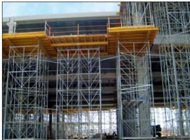
Su principal característica es garantizar una carga de utilización en torno a los 60 kN por pie en un rango de alturas comprendiendo entre los 4 m y los 12 m bajo condiciones normales. Se trata por tanto de una cimbra diseñada para el apeo de puentes o similares y de grandes losas.
