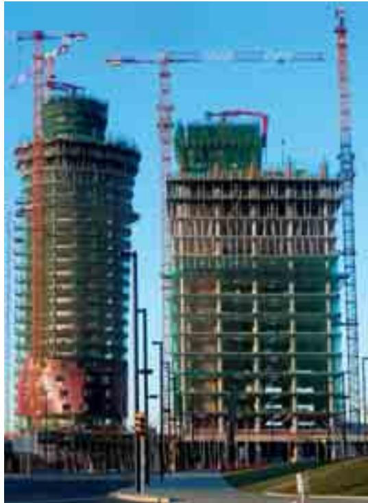
La elevación del sistema se realiza mediante la sucesiva elevación del mástil y del conjunto consola/encofrado, a lo largo del muro.
