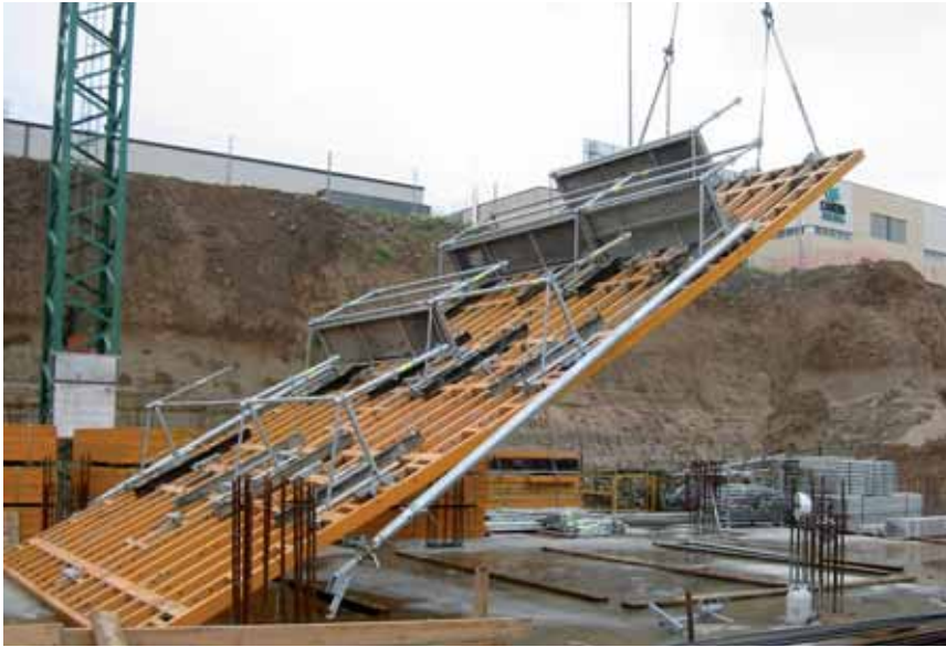
▲ Se recomienda el empleo de dos ganchos para el izado
