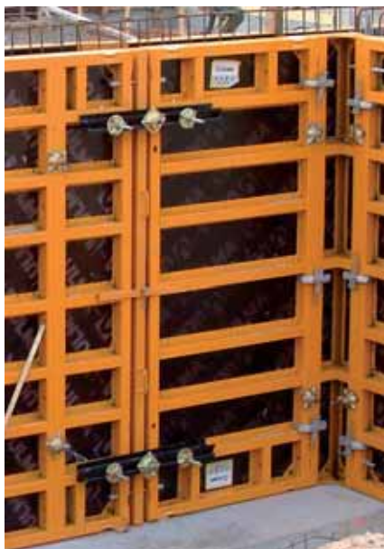
▲ Rigidizadores en compensación
