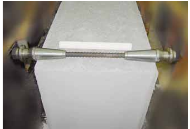
▲ Sistema de apoyo de Consola de trepado
