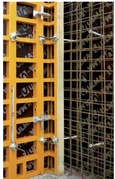
▲ Sección sistema anclaje
