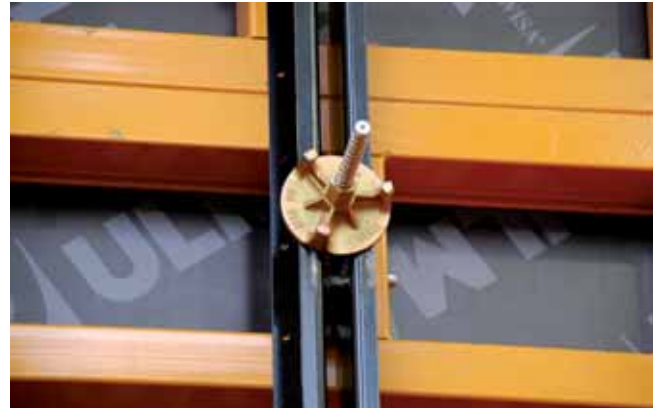
▲ Detalle de la Clavija Rigidizador
