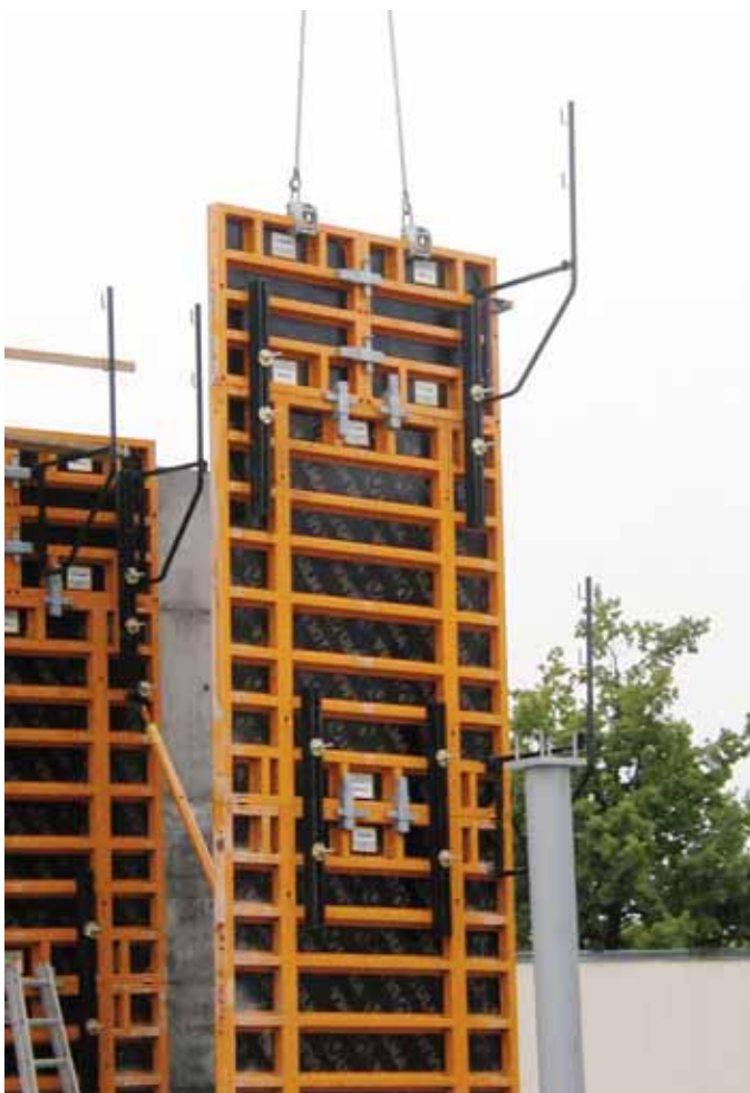
▲ Detalle anclaje del gancho al panel
