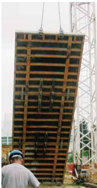
▲ Estas piezas aportan rigidez y estabilidad en el izado
