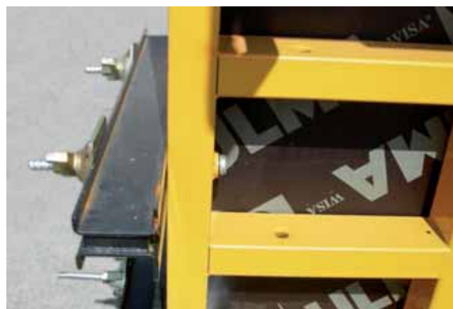
▲ Fijación del rigidizador al panel con Espárrago de Unión
