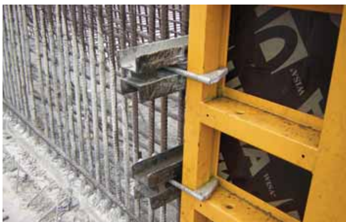
▲ Fijación del Rigidizador mediante ganchos de Cierre amarrados al perfil
