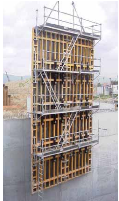
▲ Elevación de conjuntos con plataformas de trabajo a distinto nivel
