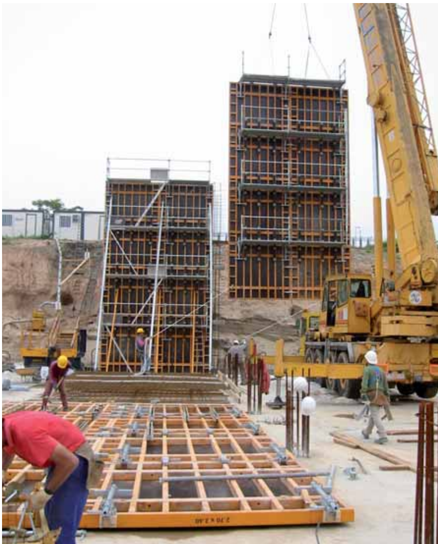
▲ Elevación de conjuntos con plataformas de trabajo a distinto nivel
