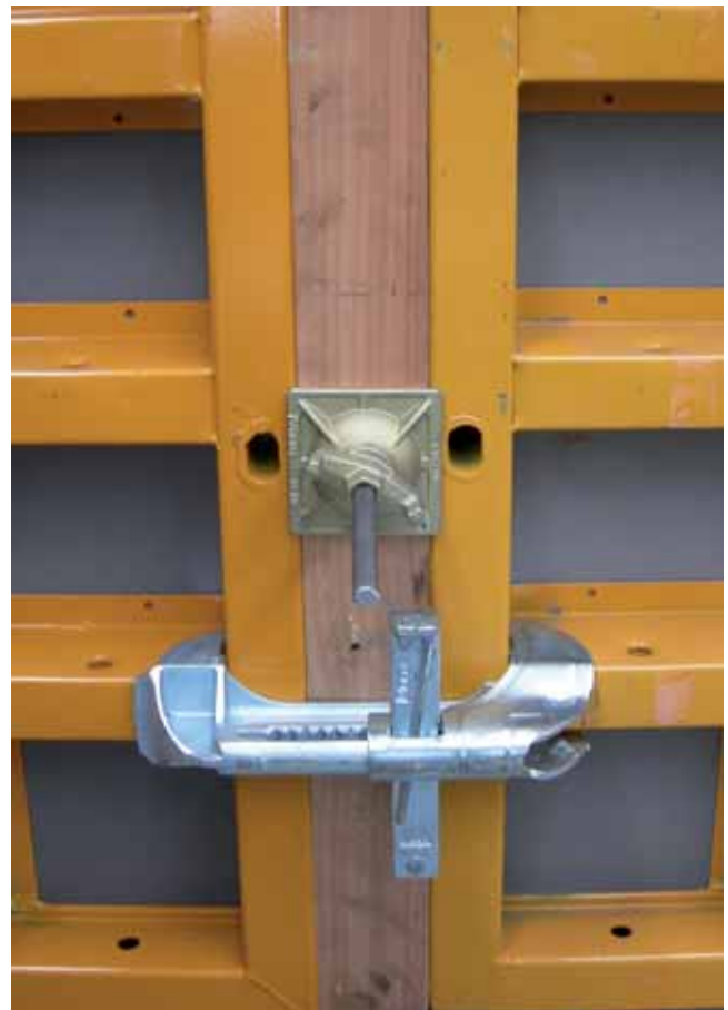
▲ La regulación de la grapa permite abarcar compensaciones de hasta 10 cm entre paneles
