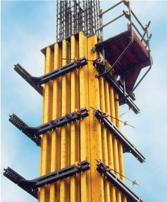
▲ Unión exterior de paneles con Cabezal escuadra exterior
