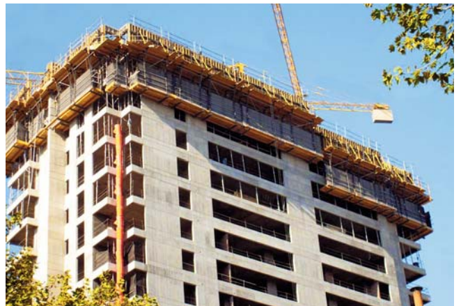
▲ El encofrado trepante se desplaza de forma vertical a grandes alturas
