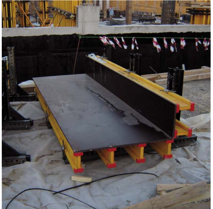
▲ Preparación de paneles para pilar en "L"
