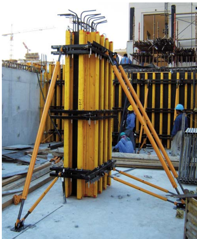
▲ Pilar estabilizado con tensores
