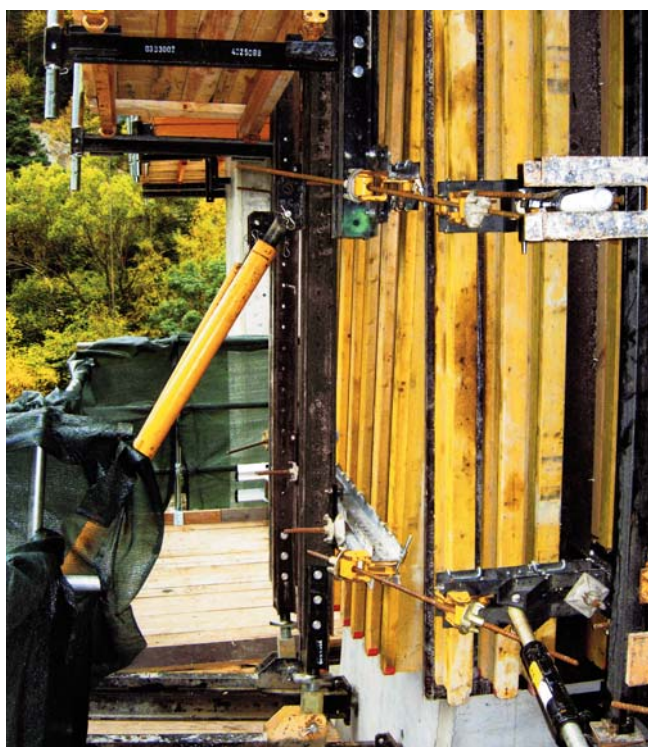
▲ Conexión entre encofrado y consola de trepado ▲
