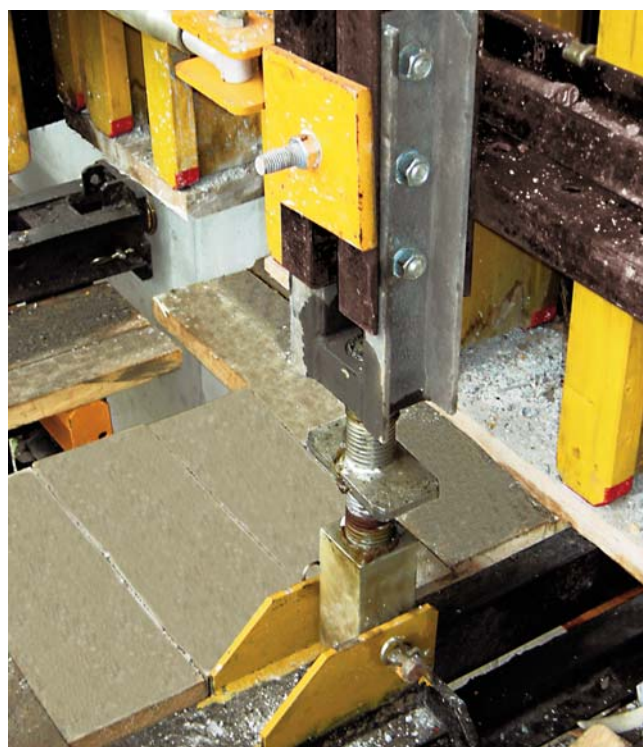
▲ Conexión entre encofrado y consola de trepado ▲
