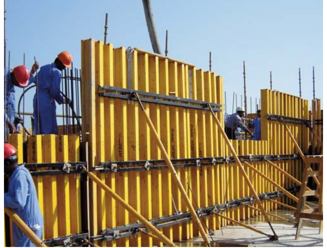
▲ Proceso de vibrado
