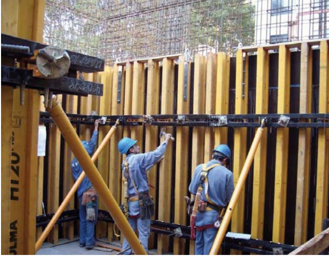
▲ Colocación de anclajes
