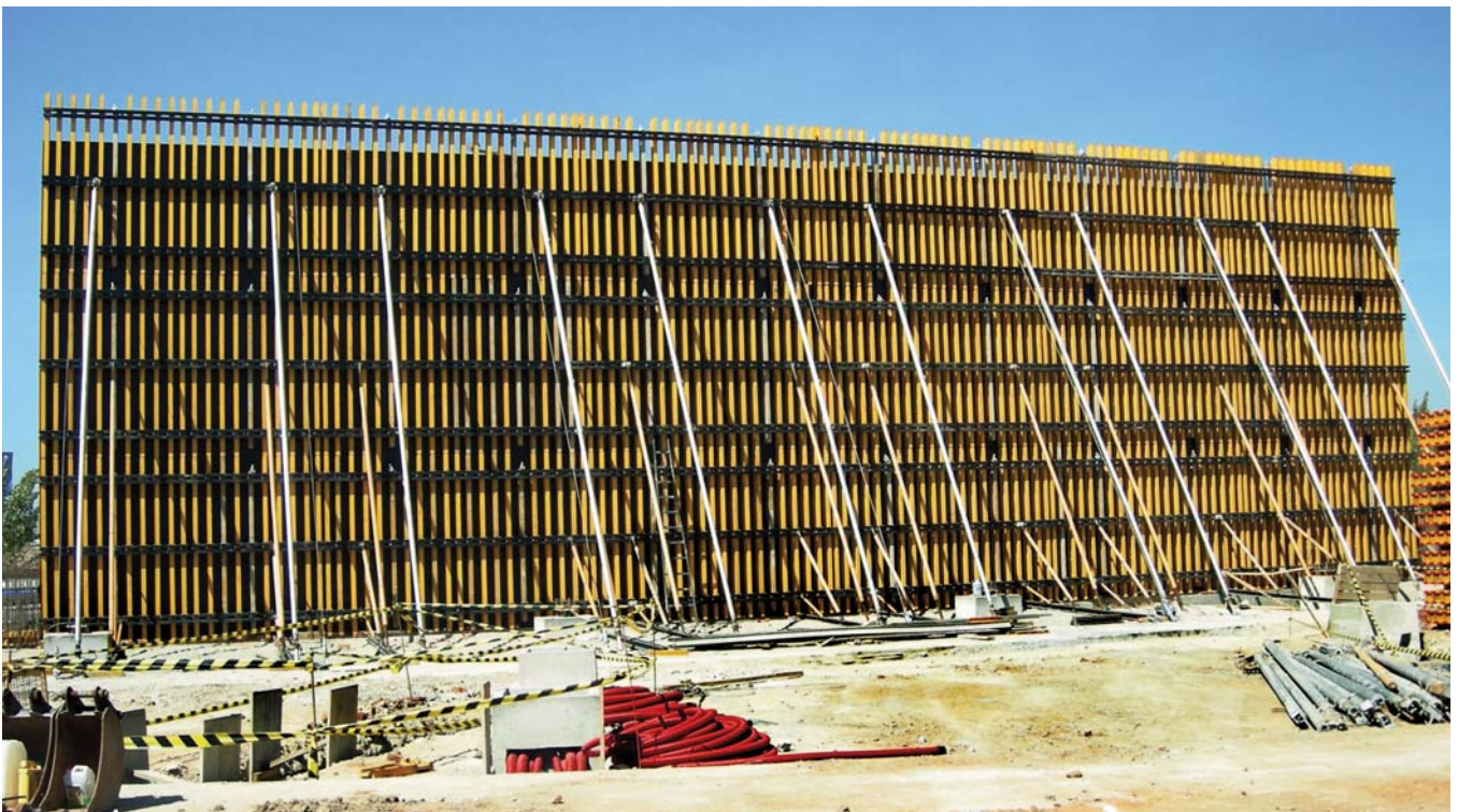
▲ Estabilización de Paneles de gran altura
