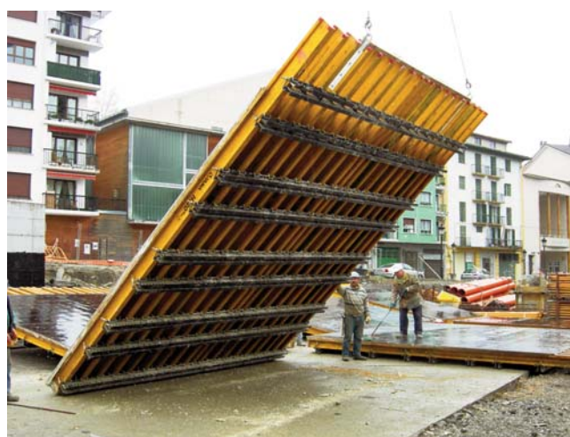
▲ Deben emplearse dos ganchos de izado por panel
