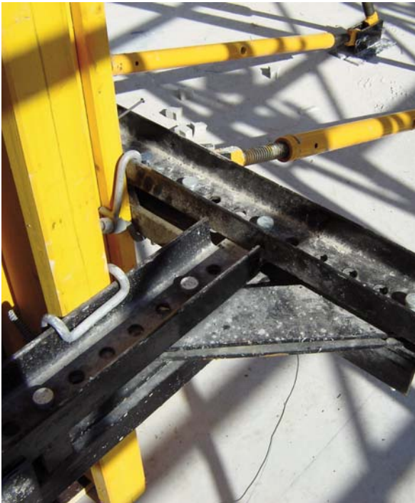
▲ Unión exterior de paneles con Regleta pilares
