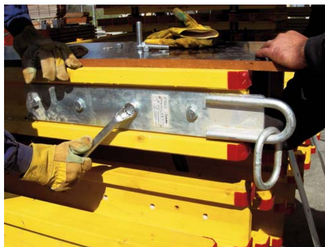
▲ Colocación del Gancho de izado en el alma de la viga
