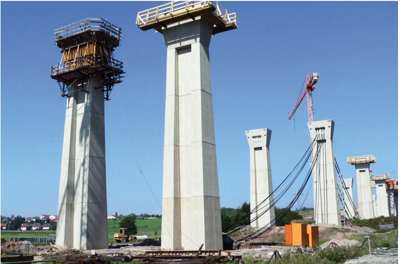
▲ Ejecución de pilas con consolas de trepado y sistema ENKOFORM V-100
