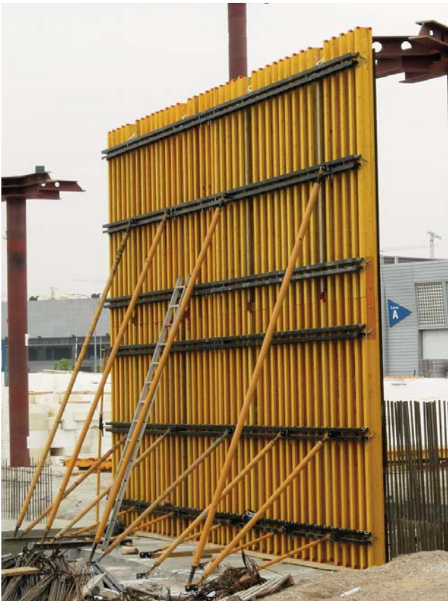
▲ Panel con vigas unidas longitudinalmente
