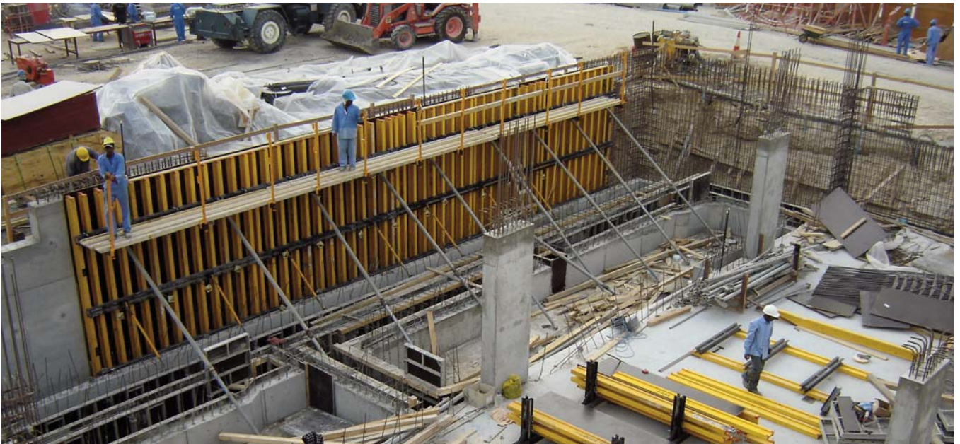
▲ Ejecución de muros y pilares
