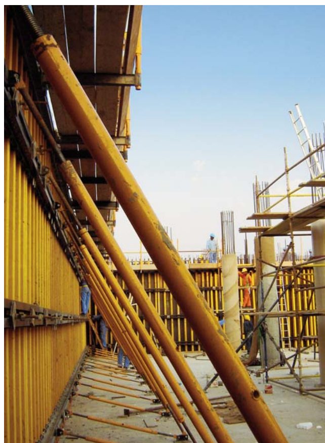
▲ Conjunto de paneles estabilizados con tensores
