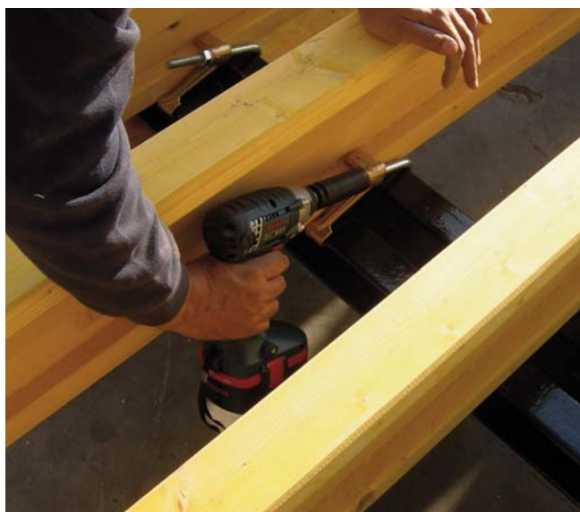
▲ Proceso de instalación de la Unión RVM20 2T ▲
