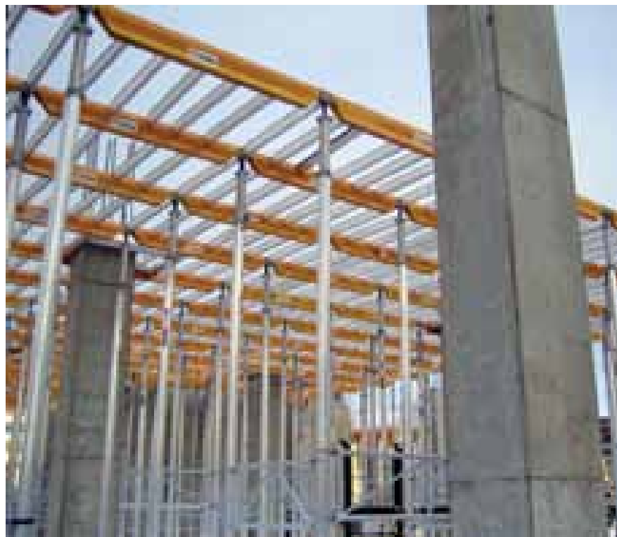
▲ Montaje de retícula Sistema CC-4 Ply
