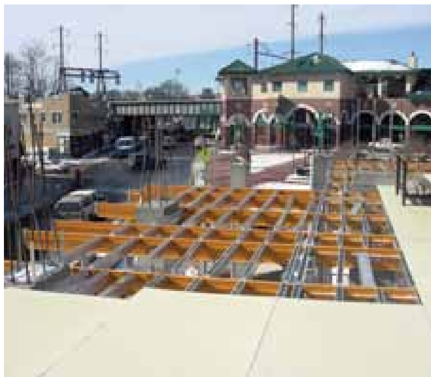
▲ Montaje de tableros Sistema CC-4 Ply
