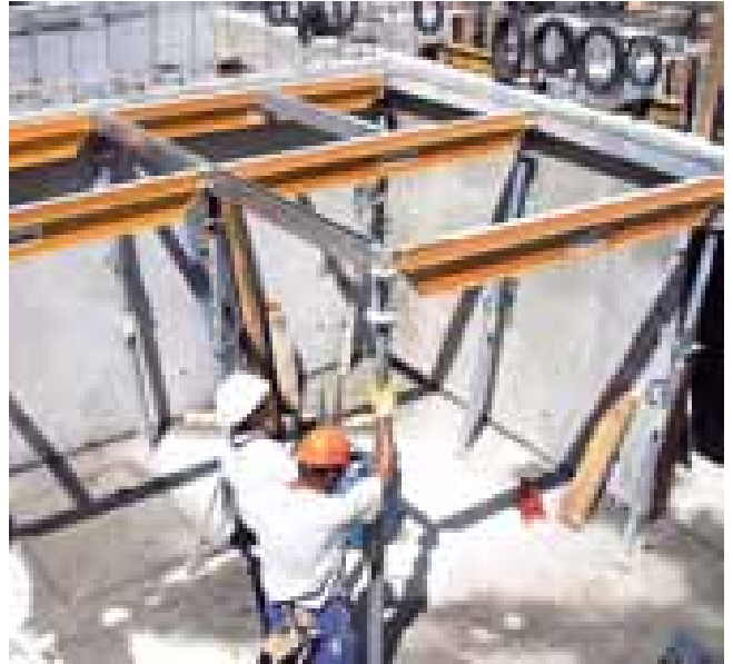
▲ Montaje de retícula Sistema CC-4 Ply
