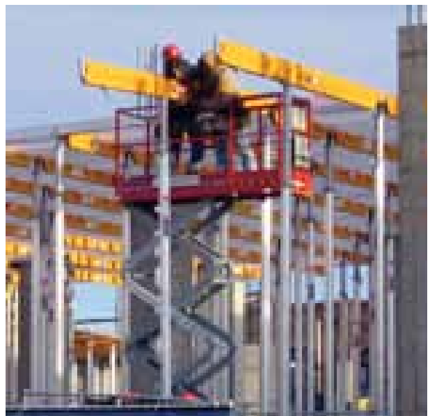
▲ Montaje de Vigas perimetrales CC
