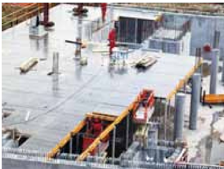
Montaje de Paneles CC ▶ desde plataformas elevadoras
