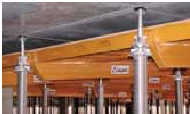
▲ Detalle de encofrado
