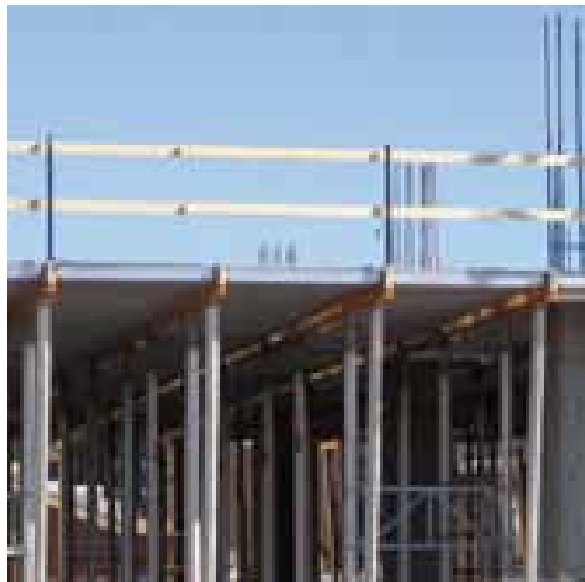
▲ Viga perimetral CC, que posee el alojamiento para el Pie de barandilla en su extremo ▲
