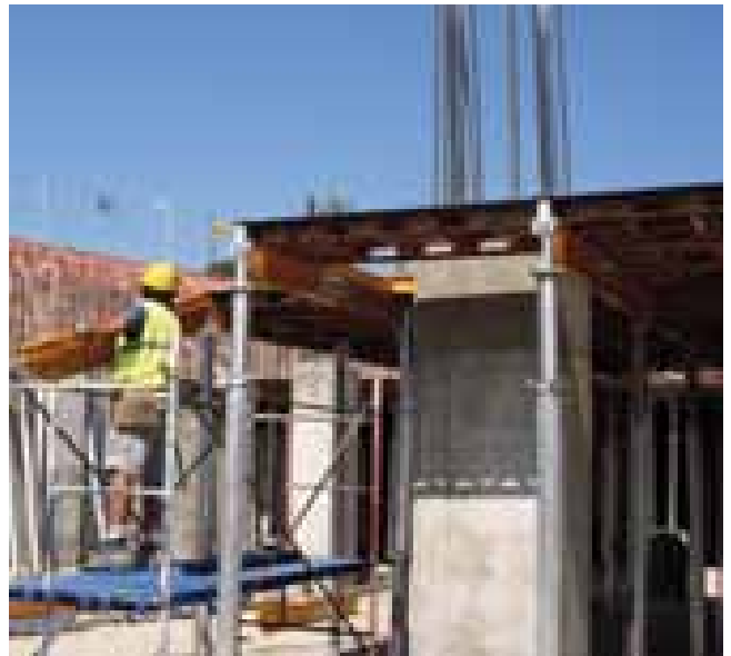
▲ Montaje de Vigas CC
