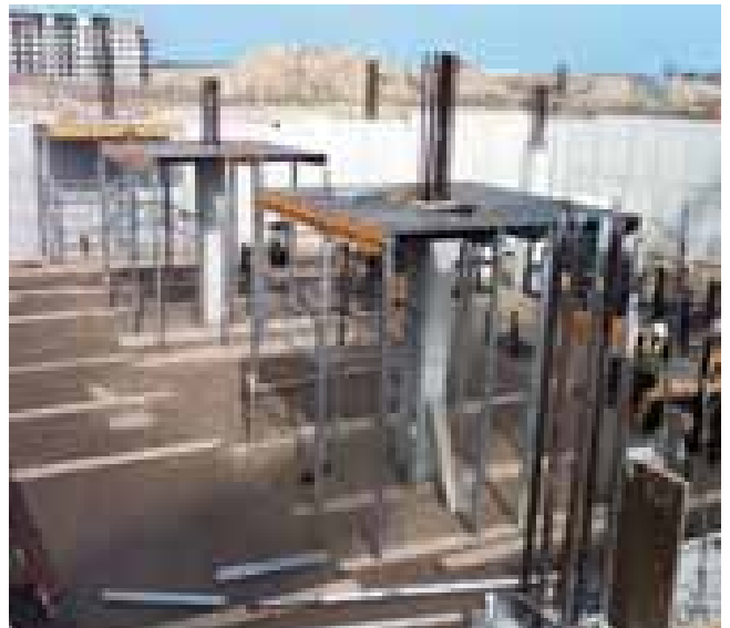
▲ Comienzo de montaje en zona de capiteles
