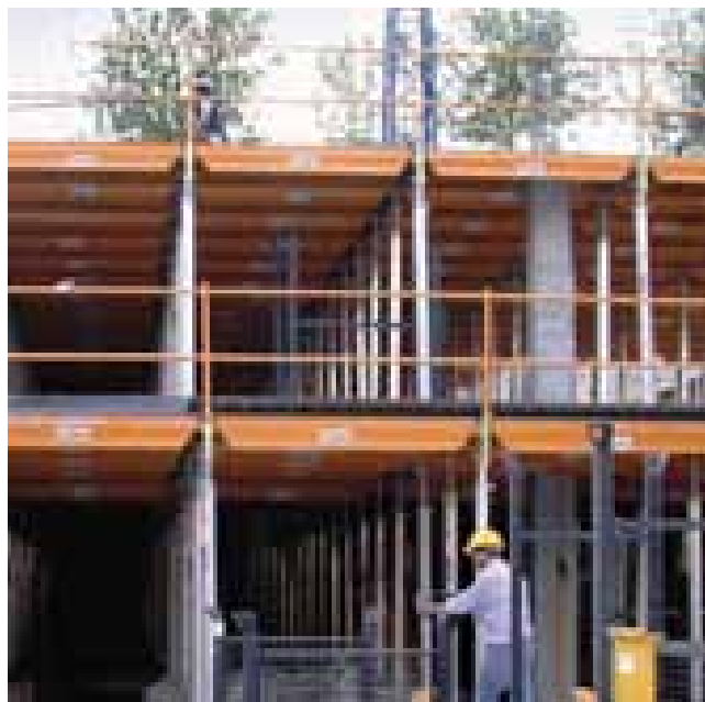
▲ Barandilla perimetral que ofrece seguridad en el proceso de ejecución ▲
