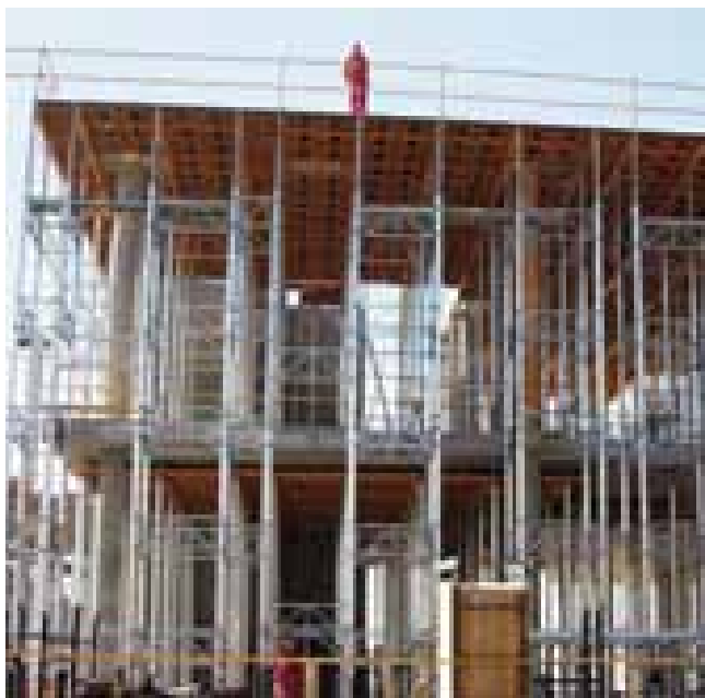
▲ Barandilla perimetral que ofrece seguridad en el proceso de ejecución ▲
