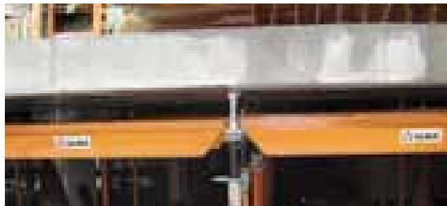
▲ Sistema CC-4 Panel en fase de desencofrado
