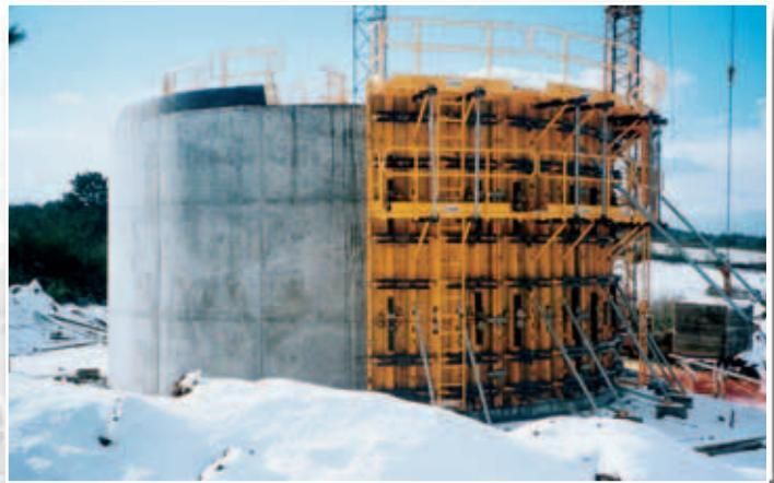
**A**lternativamente, también se pueden utilizar las Ménsoles de trabajo que, colocadas sobre paneles, sirven de plataforma para el hormigonado del muro. El amarre a los paneles se realiza por medio de bulones y pasadores que llevan incorporados.
