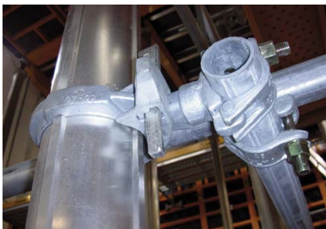
▲ Amarre de la Garra abrazadera al puntal ALUPROP
