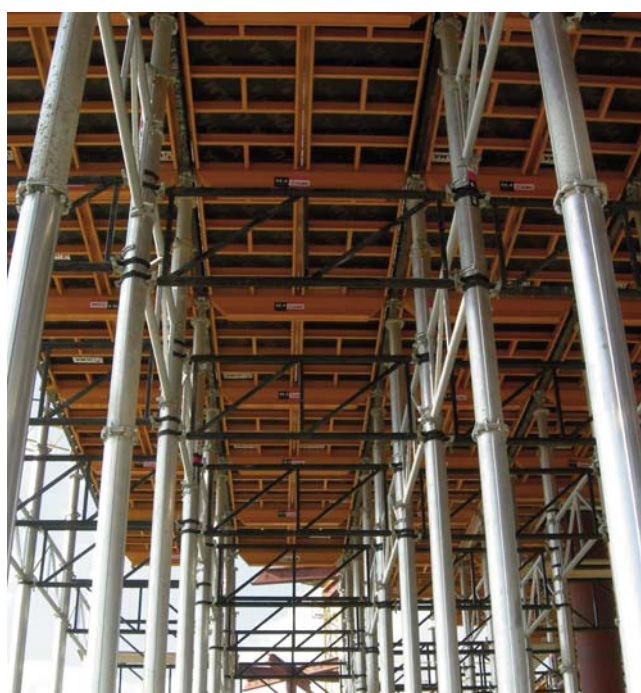
▲ Puntales superpuestos en torre ALUPROP
