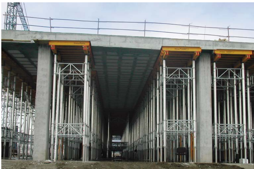
▲ Puntal de Aluminio ALUPROP formando torres en encofrado Mesa VR
