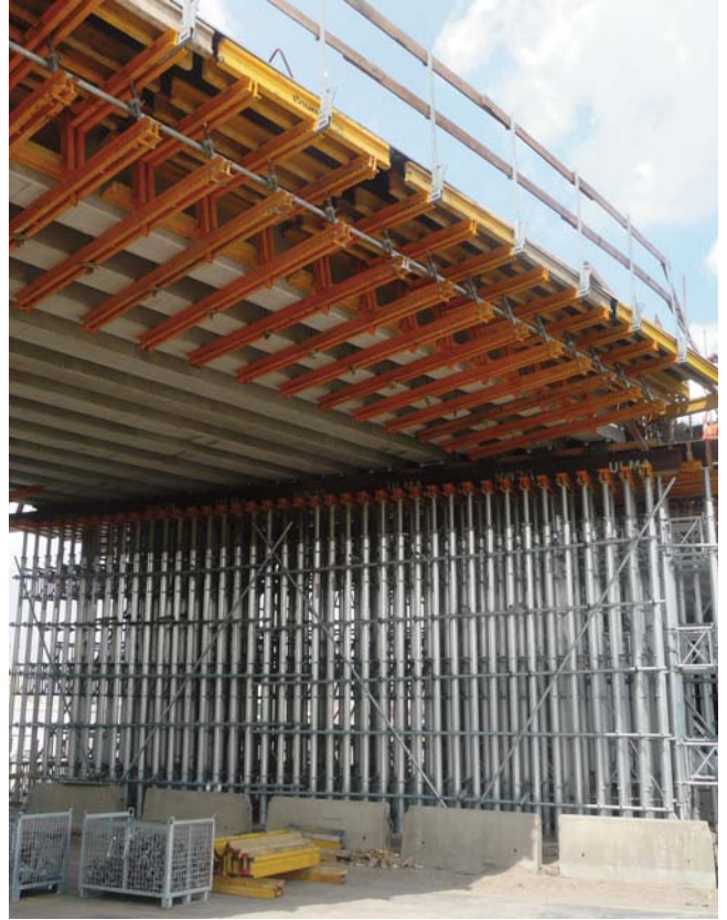
▲ Apeo de grandes cargas en ejecución de viaducto mediante aportamientos
