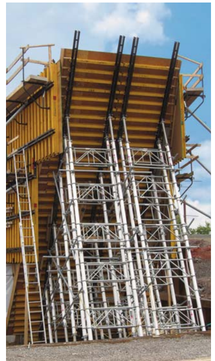
▲ Aplicación en cara inclinada de estribo
