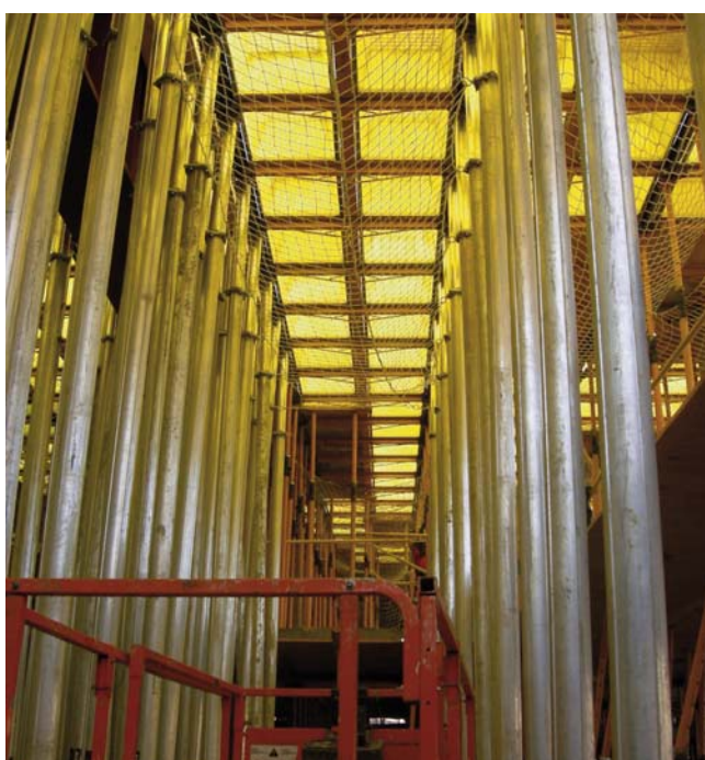
▲ Puntal ALUPROP con Suplemento 1 m apeando Encofrado Recuperable Cubetas RECUB a 7 m de altura
