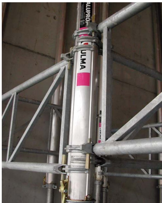
▲ Puntal de Aluminio ALUPROP más suplemento apeando encofrado RECUB a 7 m de altura
