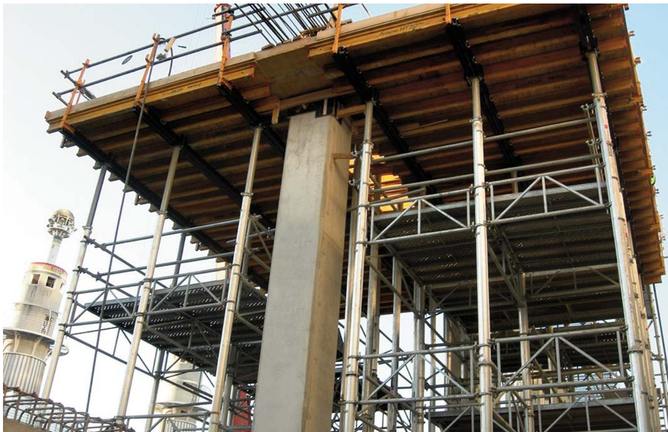
▲ Plataformas de trabajo en torres ALUPROP
