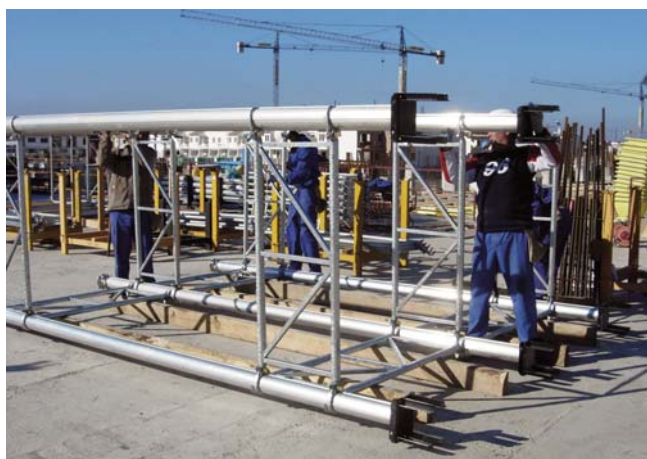
▲ Montaje de torre ALUPROP en horizontal
