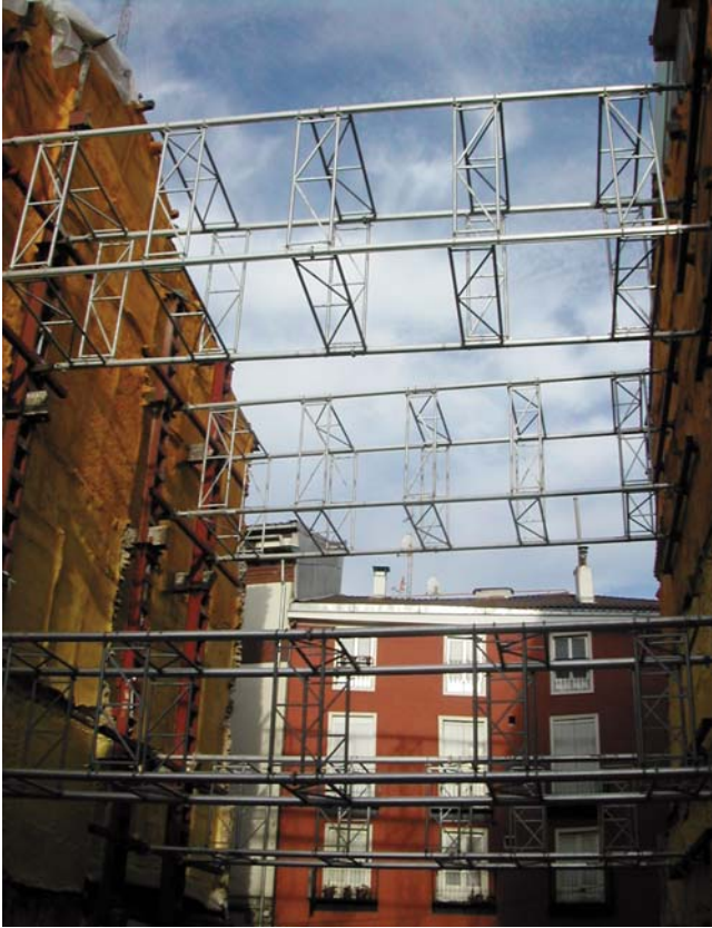
▲ Estabilización horizontal de fachadas
