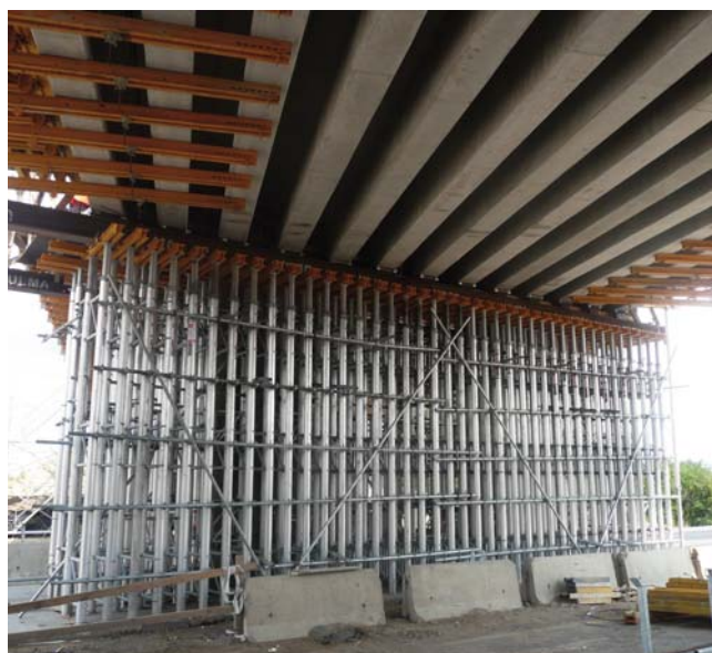
▲ Arriostramiento puntales ALUPROP mediante tubos y garras
