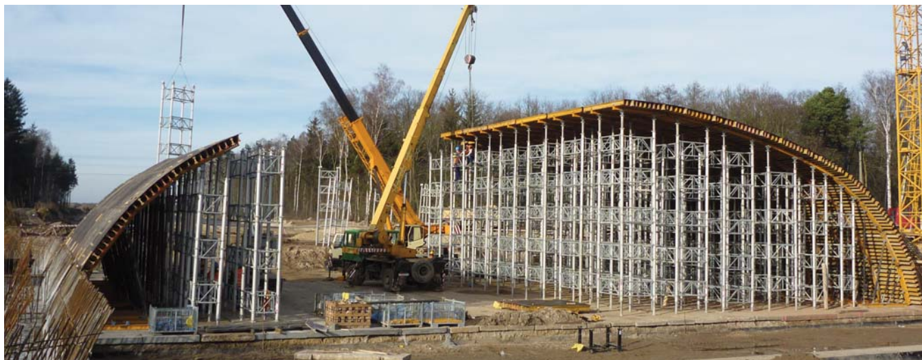
▲ Apeo de falso túnel en arco
