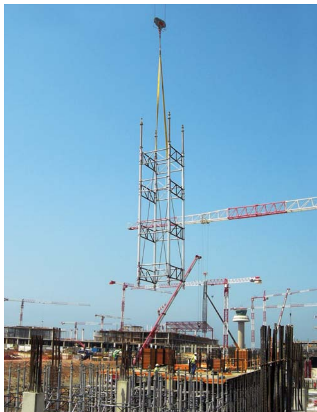
▲ Izado de torre ALUPROP con grúa
