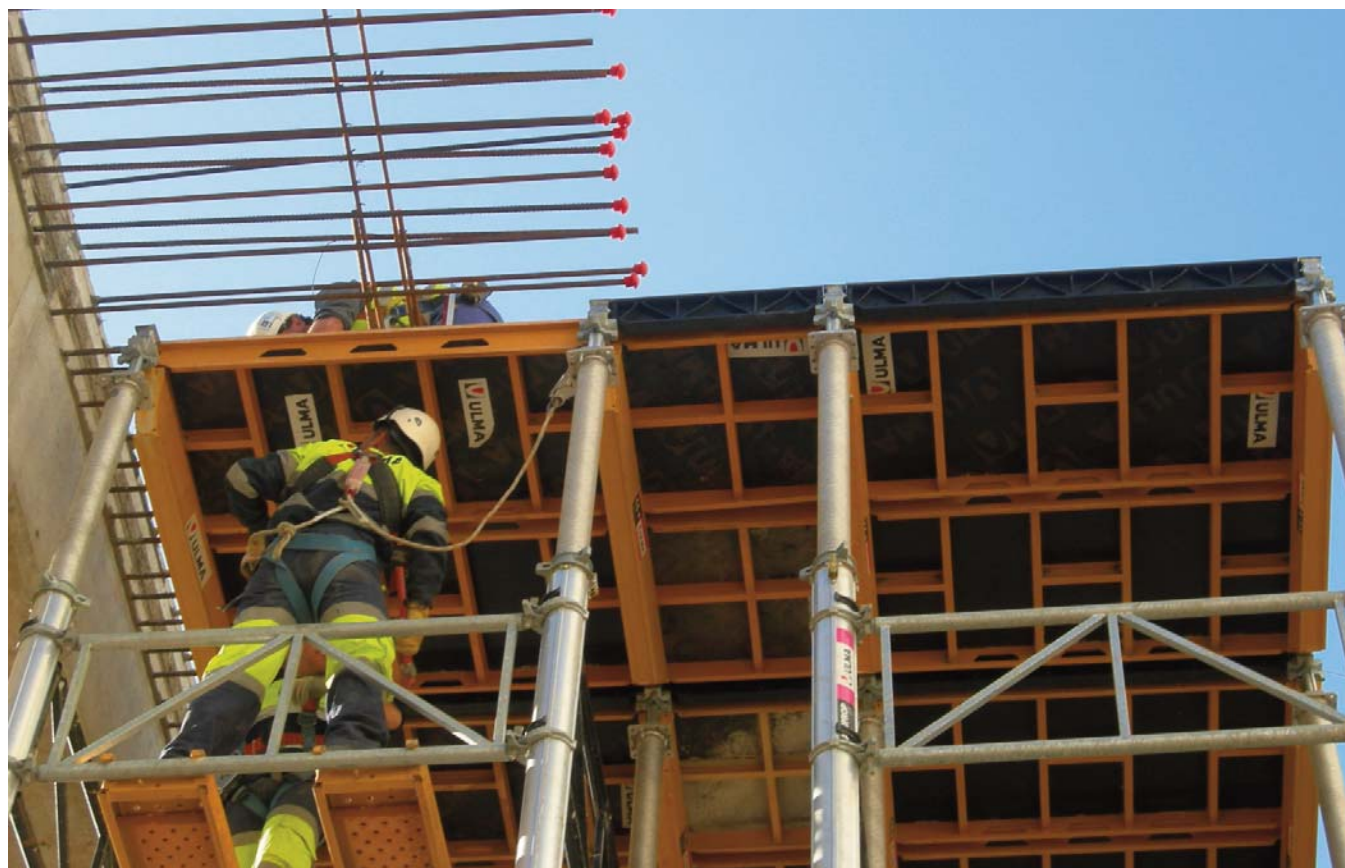
▲ Montaje del encofrado de aluminio CC-4 desde plataformas situadas sobre marcos de arriostramiento de torres ALUPROP
