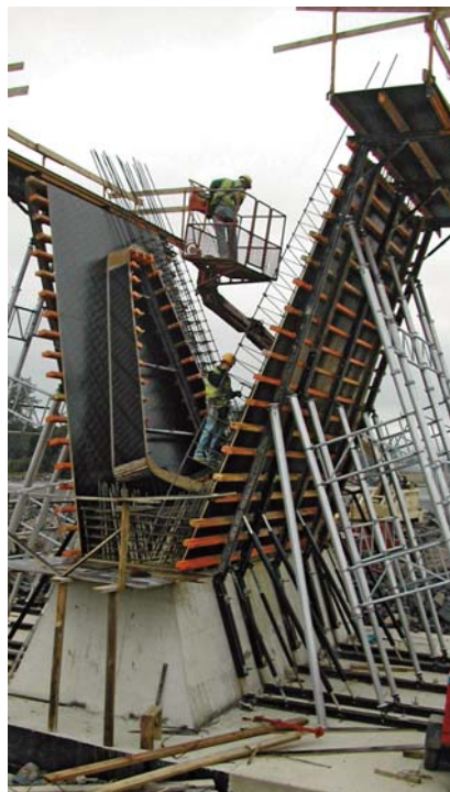
▲ Apeo de pilar inclinado ejecutado con Encofrado Vertical ENKOFORM V-100
