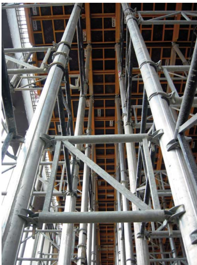
▲ Amarre de la Garra abrazadera al puntal ALUPROP
