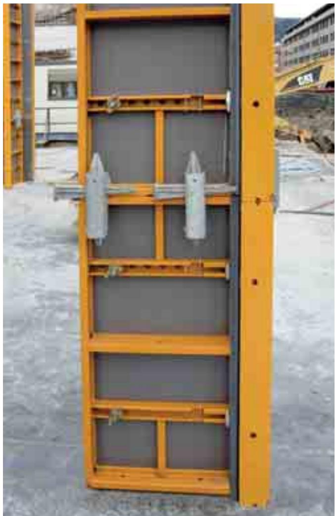
▲ Unión en altura de los paneles con dos grapas
