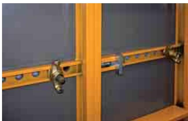
▲ Unión de paneles con Tuerca desplazable
