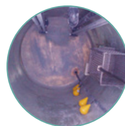
pozos de bombeo
