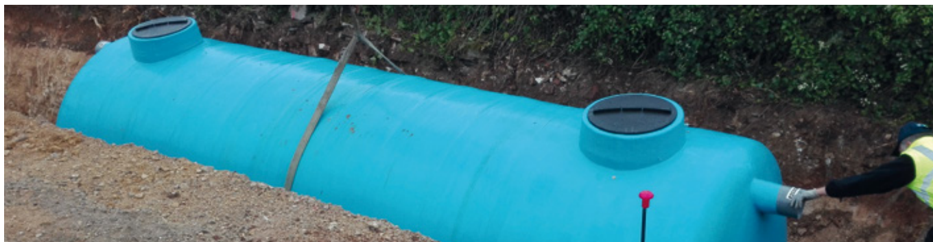
Instalación depósito DRP
