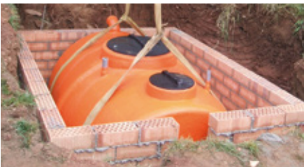
NECOR 5 vivienda unifamiliar
