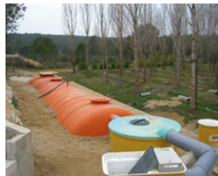
Instalación depuradora perfil hidráulico
