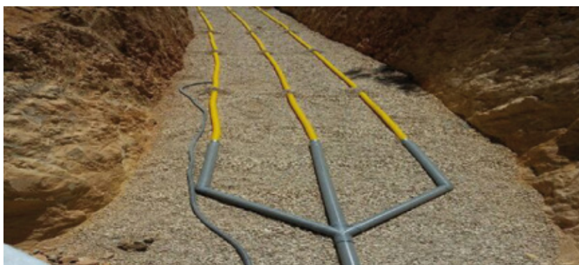
Tubos de drenaje sobre grava en zanjas
