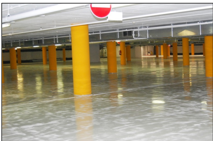
Regularización: StoPur IB 500
