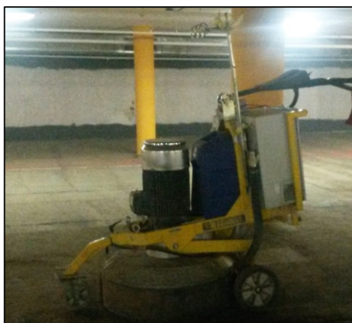
Preparación: pulido con diamante
