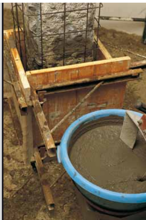
foto 10 Struttura ripristinata con Mapegrout Colabile
