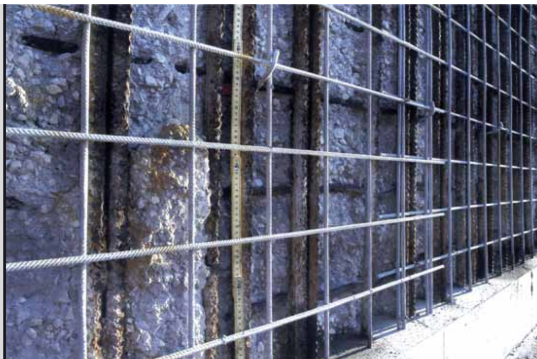
foto 4 Posizionamento di nuova armatura
