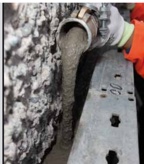
foto 11 Applicazione di Mapegrout Colabile GF
