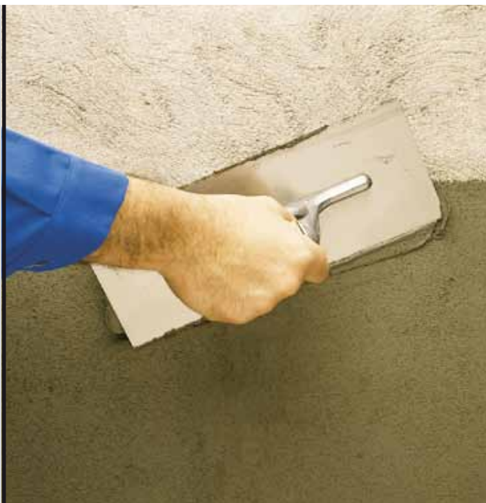
foto 17 Rasatura con Mapefinish
