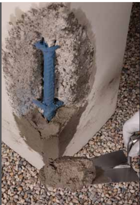
foto 10 Applicazione di MAPEGROUT LM2K
