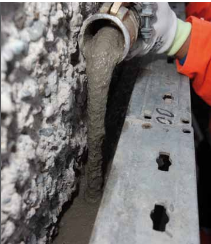
foto 13 Applicazione di Mapegrout Colabile GF
