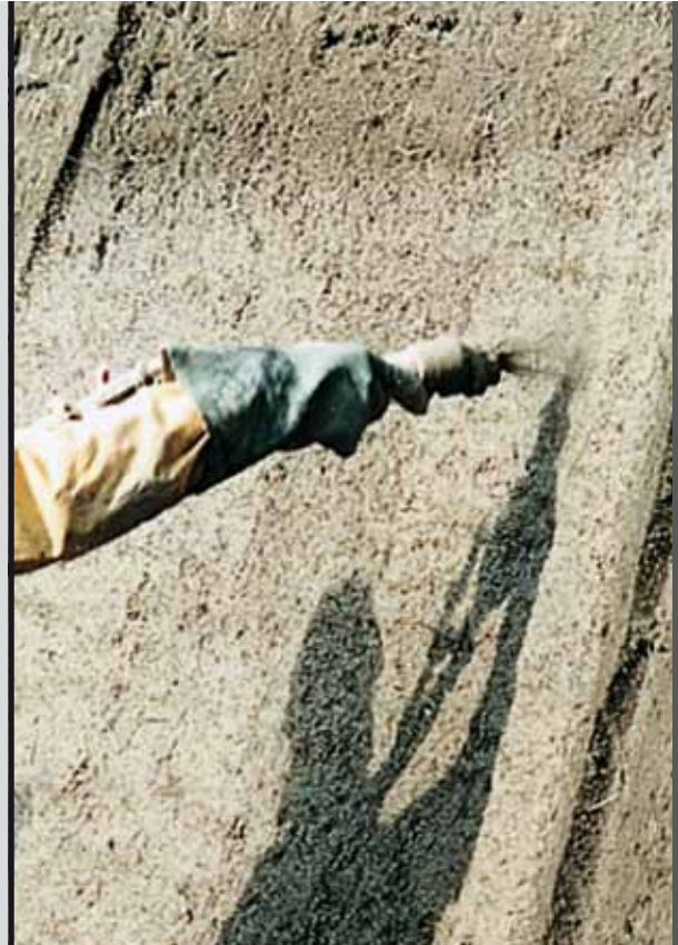
foto 8 Applicazione a spruzzo di Mapegrout FMR
