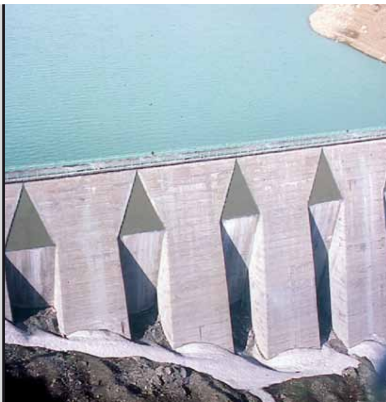
foto 17 Struttura impermeabilizzata con Mapelastic
