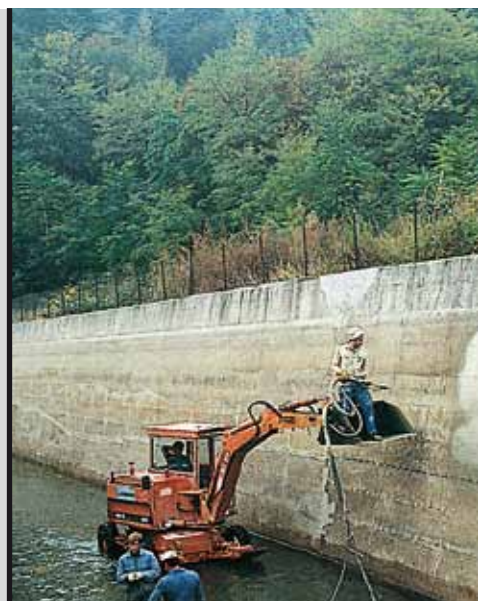
foto 18 Applicazione di Idosilex Pronto
