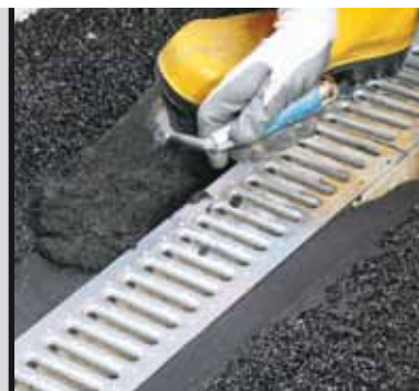
foto 9 Fissaggio di una griglia di scolo con Mapegrout SV T
