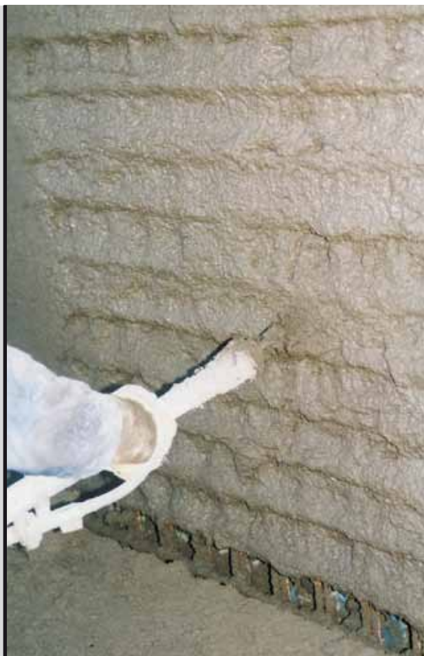
foto 5 Applicazione a spruzzo di Mapegrout Easy Flow GF
