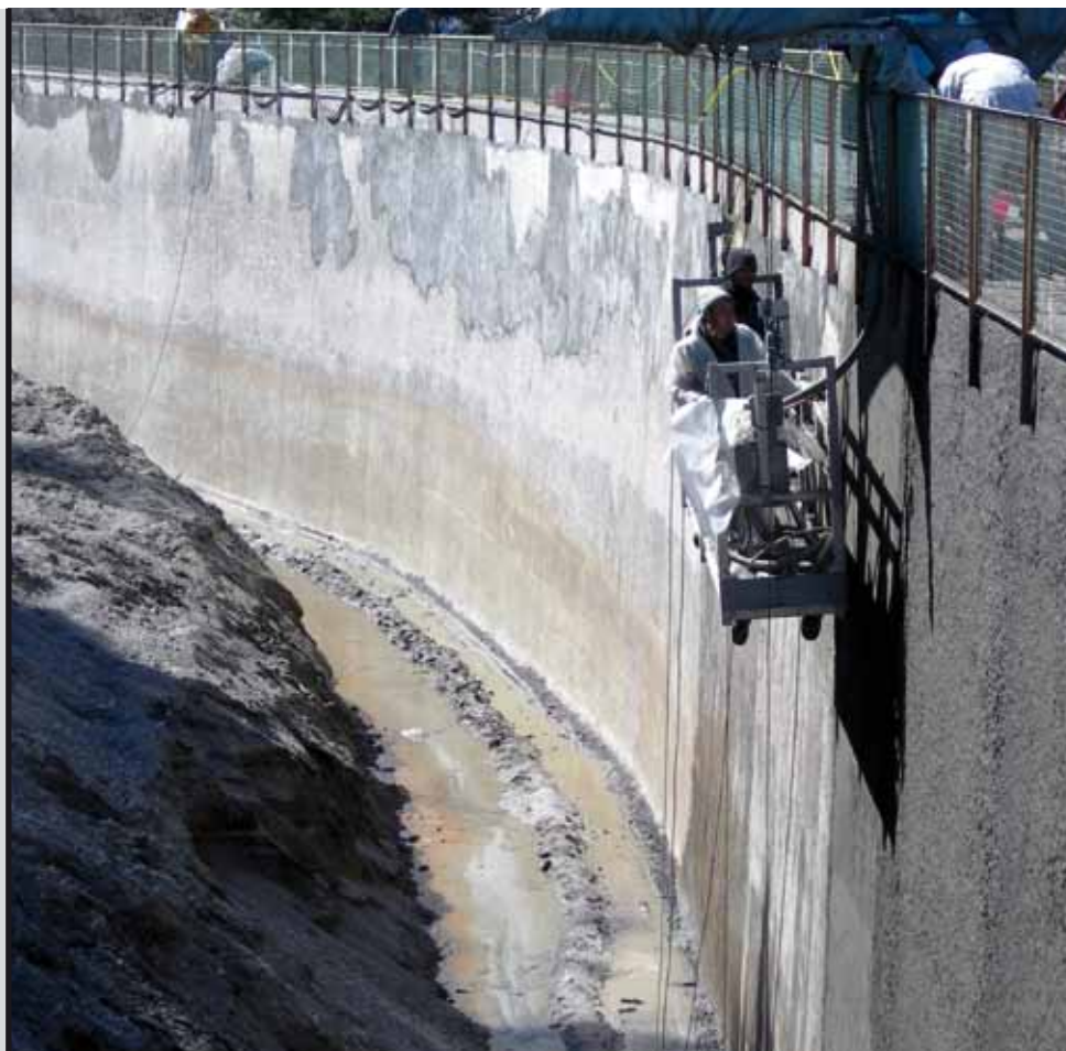
foto 7 Applicazione a spruzzo di Mapegrout BM
