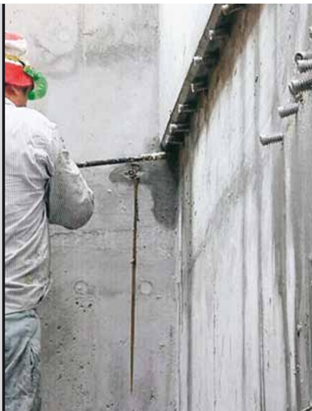
foto 15 Iniezione con Foamjet F
