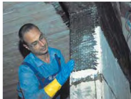
Figura 2 Refuerzo estructural "armado" de edificios de albañilería
