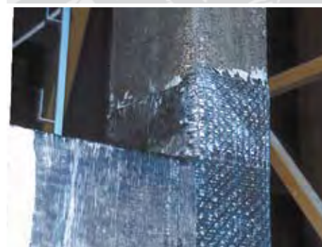
Figura 4 Enfajado de pilares y vigas
