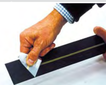
Figura 21 Eliminación de la película protectora de CARBOPLATE
