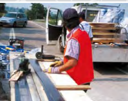
Figura 22 Preparación de la lámina CARBOPLATE
