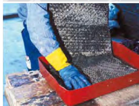
Figura 17 Impregnación manual de MAPEWRAP C
