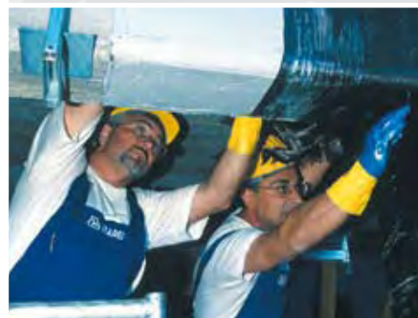
Figura 3 Enfajado de pilares y vigas
