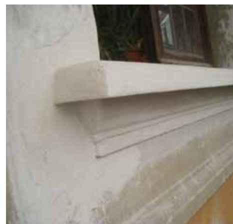
Enlucido de antepecho realizado con mortero
