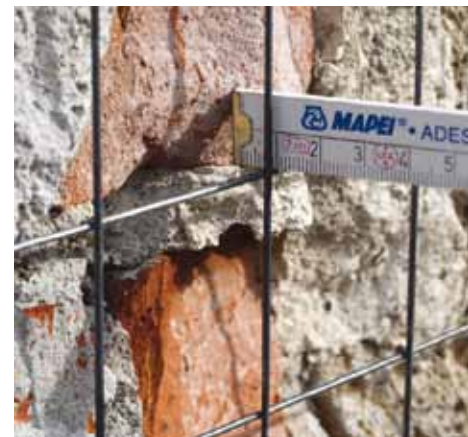
Colocación de malla galvanizada
