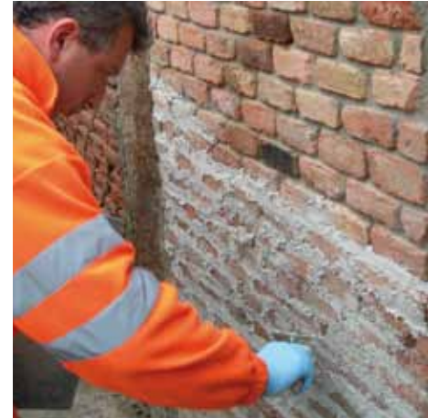
Relleno de juntas entre ladrillos
