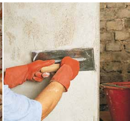
Aplicación de un enlucido fino transpirable
