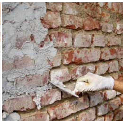
Relleno de juntas entre ladrillos
