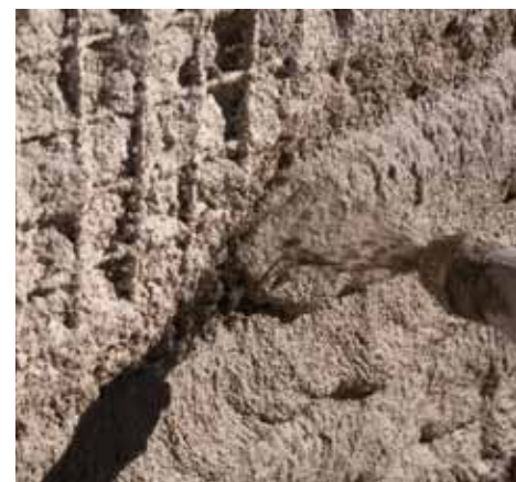
Aplicación de revoque de elevadas prestaciones mecánicas
