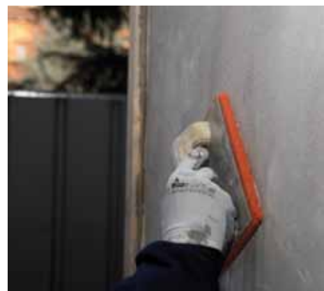
Fratasado de un revoque deshumidificante
