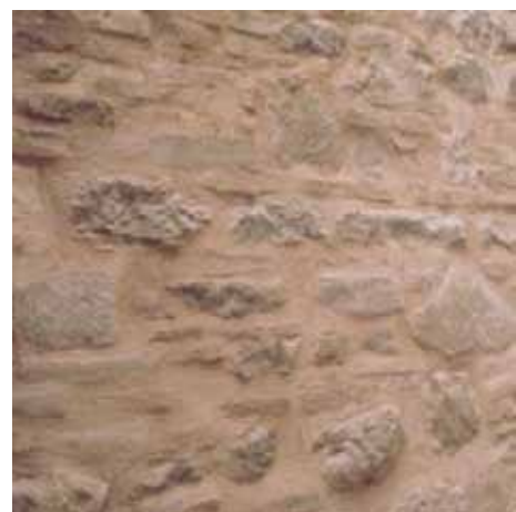
Relleno de juntas entre piedras
