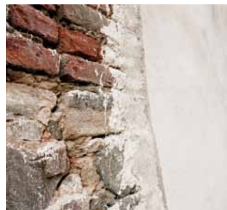
Realización de revoque deshumidificante
