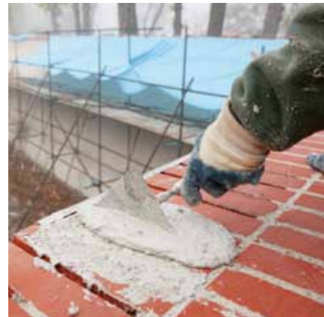
Realización de juntas de albañilería
