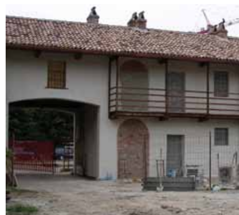
Realización de revoque deshumidificante
