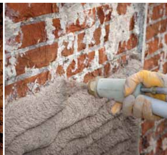
Aplicación de revoque de fondo transpirable
