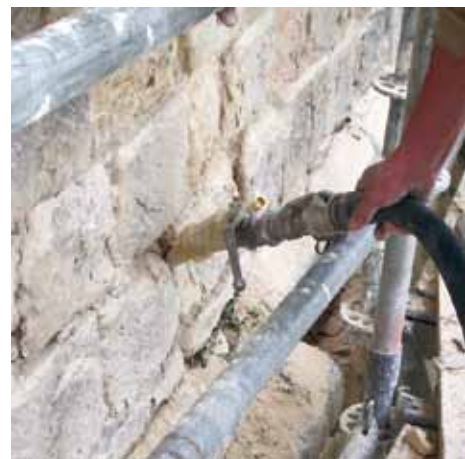
Consolidación de una mampostería "en seco" de piedra
