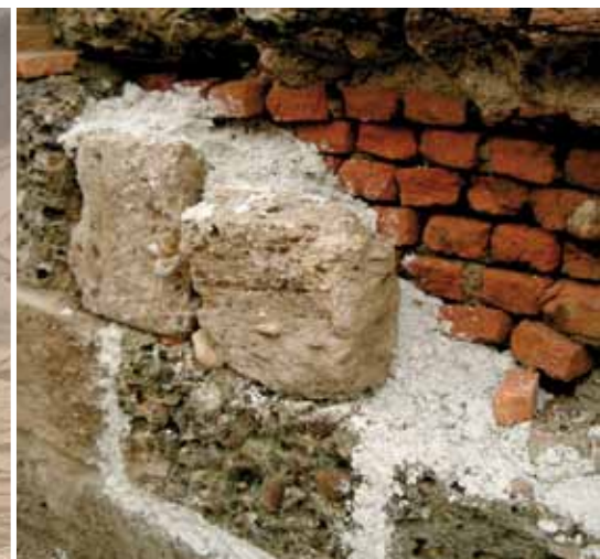
Reconstrucción de un muro
