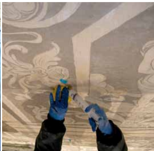
Inyección de consolidación de un revoque
