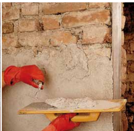
Realización de revoque deshumificante macroporoso
