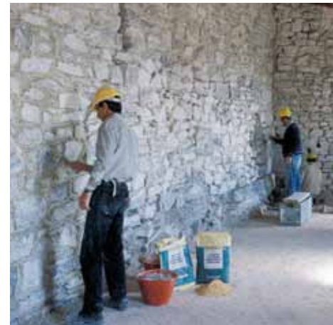
Relleno de juntas entre piedras
