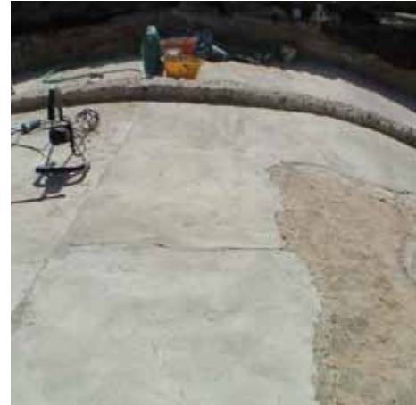
Nivelado del extradós de bóveda
