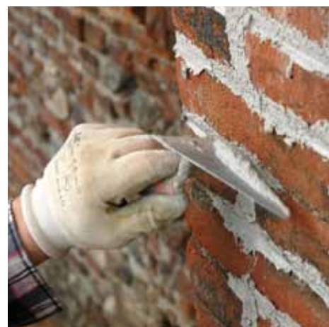
Relleno de juntas entre ladrillos
