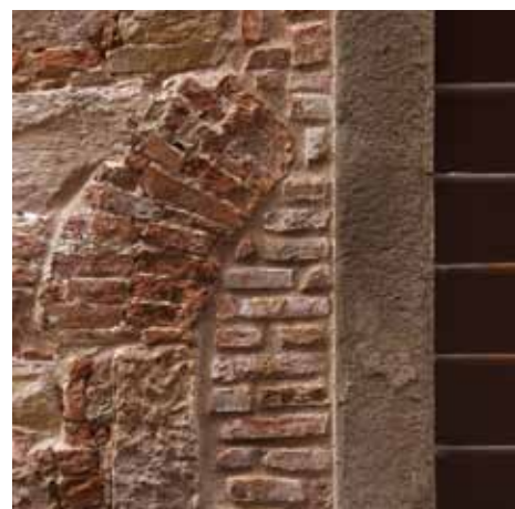
Relleno de juntas entre ladrillos
