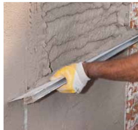
Regleado del revoque
