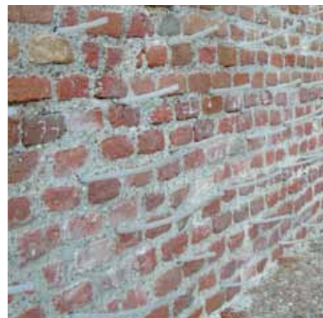
Consolidación de un muro
