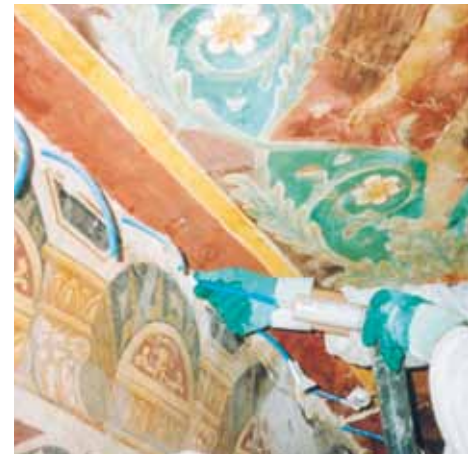
Consolidación de un revoque con frescos
