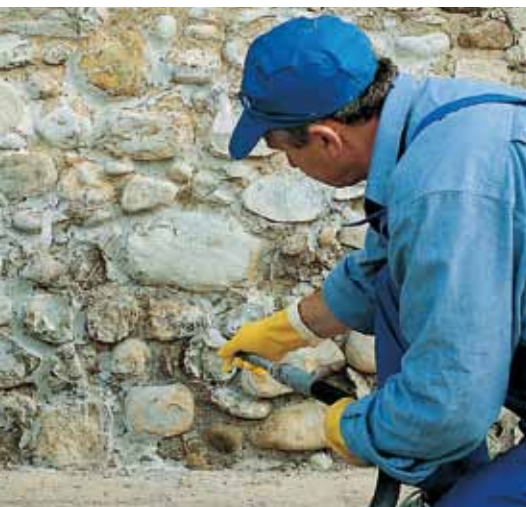
Inyección de consolidación de albañilería en seco
