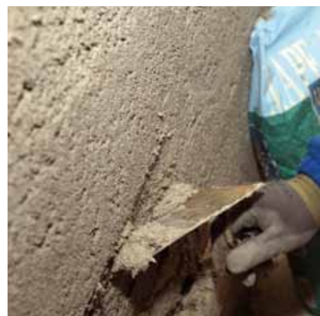
Realización de revoque deshumidificante
