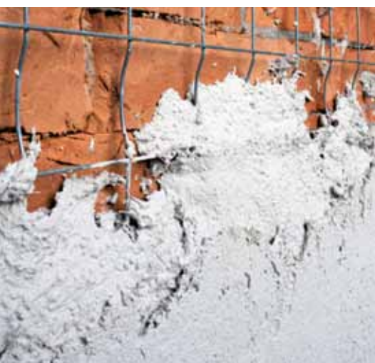
Realización de revoque "armado"
