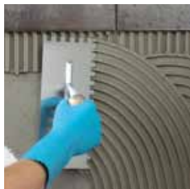
Extensión de Ultralite S1 con llana dentada
