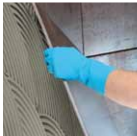
Colocación de baldosas de cerámica de gran formato
