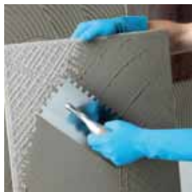
Extensión del adhesivo sobre el reverso
