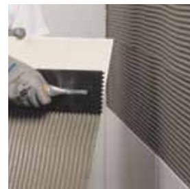
Aplicación de Ultralite S2 sobre el reverso de la baldosa
