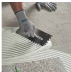
Extensión de Ultralite S1 Quick con llana dentada
