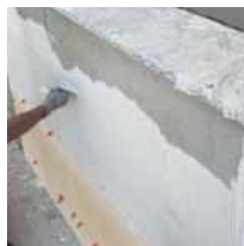
Aplicación de Ultralite S2 Quick sobre revoco
