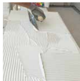
Aplicación de Ultralite S2 Quick sobre el reverso de una baldosa
