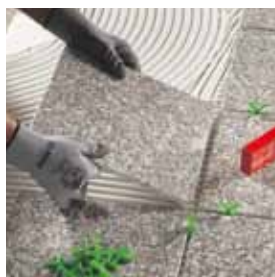
Colocación de piedra natural
