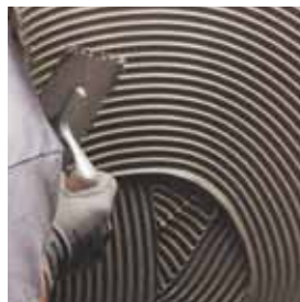
Aplicación de Ultralite S2 sobre revoco
