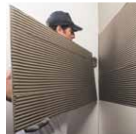
Colocación de la baldosa fina en pared
