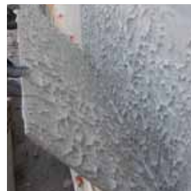
Óptima impregnación entre soporte y reverso de la baldosa
