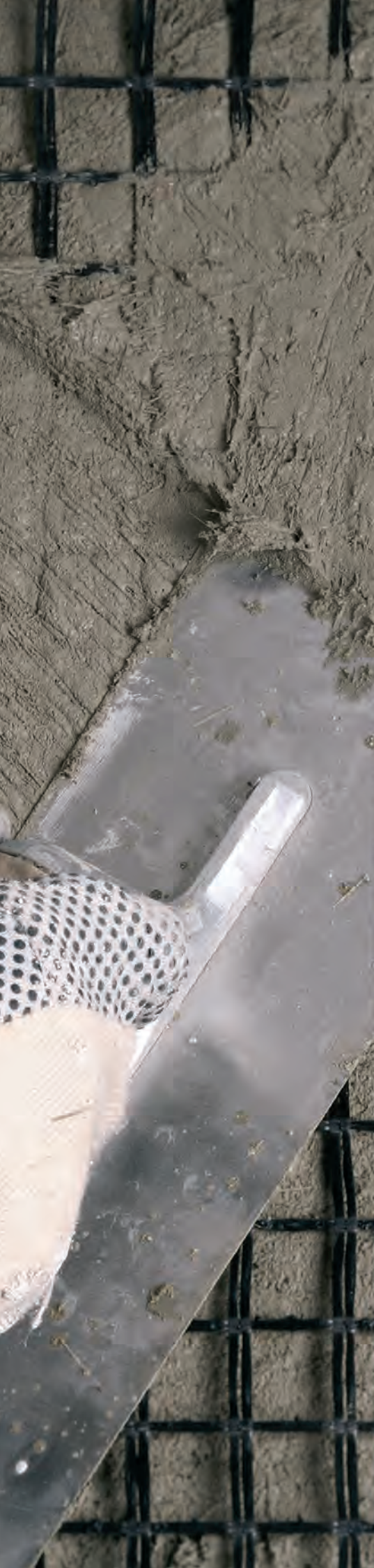
6. Cubrición de la malla MAPEGRID G220 con una mano posterior de PLANITOP HDM/PLANITOP HDM MAXI
