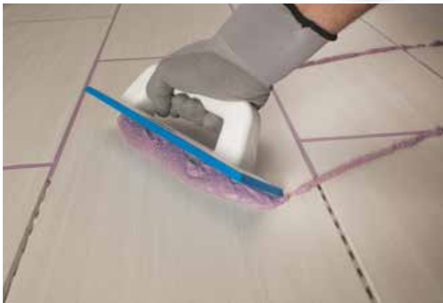
Aplicación de Kerapoxy CQ con llana Mapei
