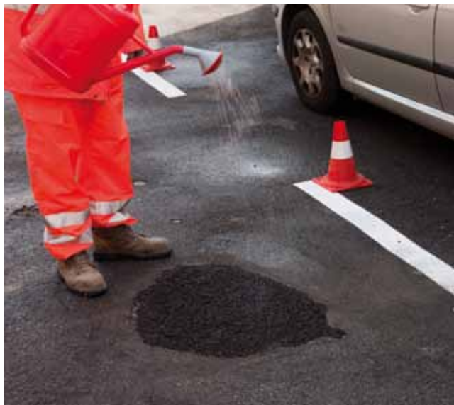
3. Humectación de la superficie de Mape-Asphalt Repair 0/8
