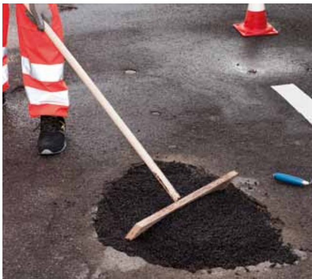
2. Aplicación de Mape-Asphalt Repair 0/8
