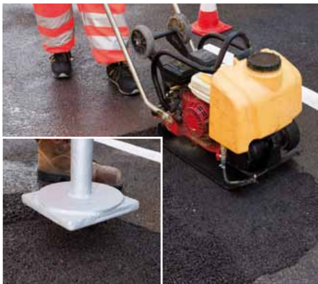
4. Compactación manual o mecánica de Mape-Asphalt Repair 0/8
