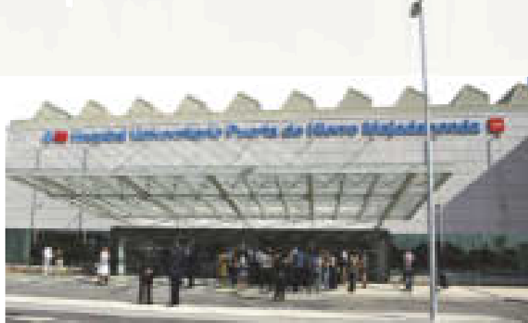
Hospital Puerta de Hierro, Madrid
