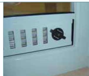
entrada de aire a través de ventilación continua montaje en zona zócalo
