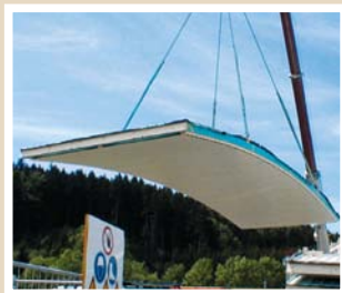
prefabricación de piezas
