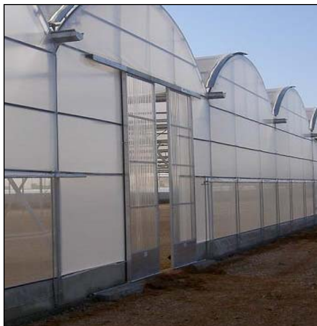
Vista di una porta di accesso standard composta da due fogli scorrevoli
