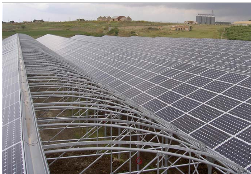
Vista sui tetti della serra con i pannelli fotovoltaici.
