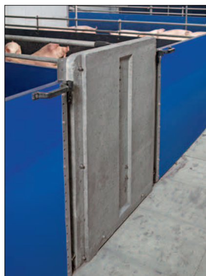
Cabezal de hormigón
