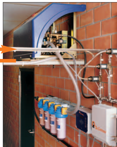
Equipo de bomba central con filtrado de 4 pasos
