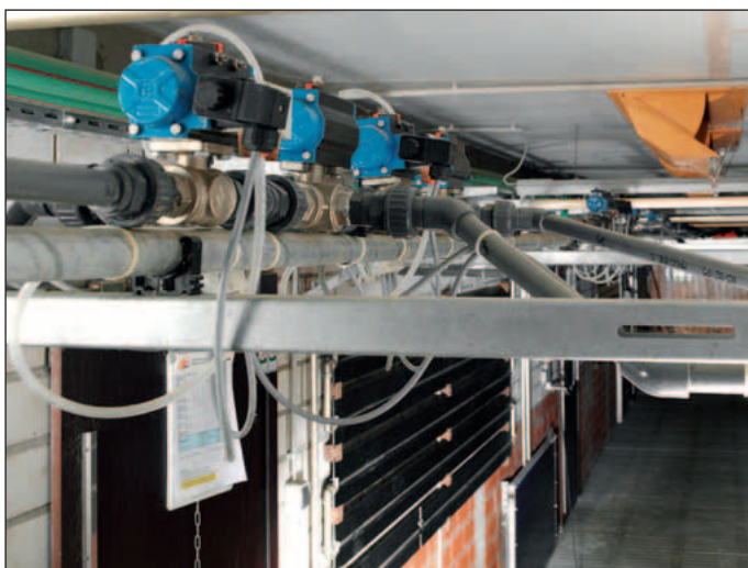
Válvulas de alimentación instaladas en el pasillo central
