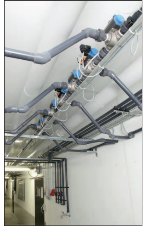
Instalación de válvulas de alimentación en pasillo central
