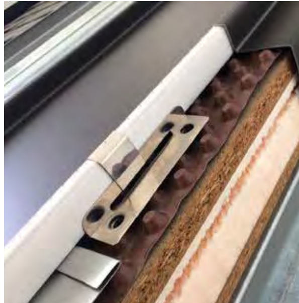
Rastrel vertical de madera, aislamiento, rastrel horizontal de madera y pizarra de cubierta
