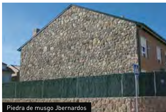
Mampostería Hueso Jbernardos
