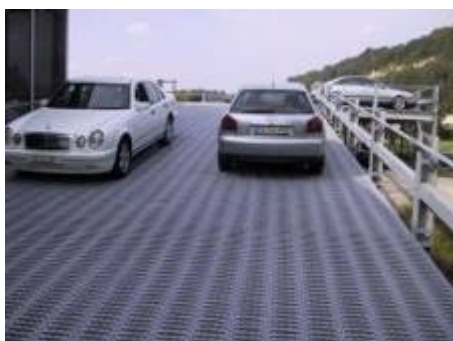
Rejilla REGLETA como rampa de acceso a un carpark, transitable por coches.
