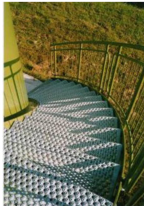
Peldaños semi-curvados en REDONDO-S - almas laterales curvadas a medida y lacadas
