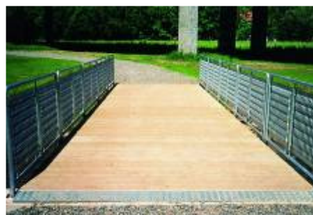
Piso ARENADO como puente peatonal. La barandilla esta realizada a través de pletinas sin pliegues de la rejilla STABIL-S.
