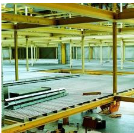
Rejilla REDONDO-S como entreplanta en la fabrica de BMW-Rover (Inglaterra).
