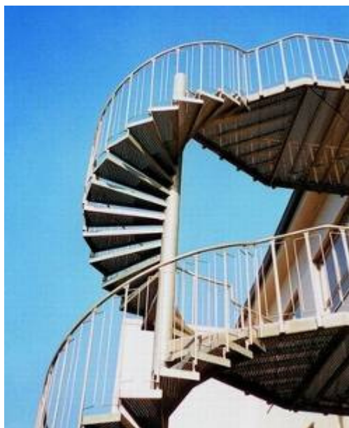
Escalera de caracol con 2 salidas - plataforma de salida tipo D extra-grande - perforación REDONDO-S - barandilla tipo GB
