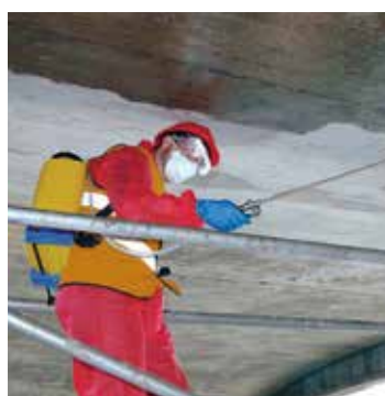
Principio 11 - método 11.3 Uso de inhibidor de corrosión para las armaduras MasterProtect 8000 CI MasterProtect 8500 CI
