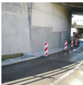
Principio 7 - método 7.2 Reemplazo de hormigón contaminado con cloruros MasterEmaco S MasterEmaco S 5300 MasterEmaco S 3000 CI
