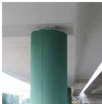
Principio 9 - método 9.1 Limitación del contenido de oxígeno en el cátodo mediante membranas impermeables o revestimientos protectores MasterSeal MasterProtect
