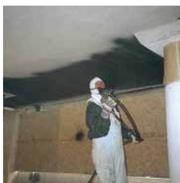
Principio 10 - método 10.1 Protección catódica del hormigón MasterProtect CP
