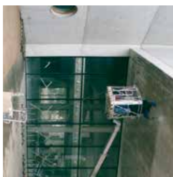
Principio 11 - método 11.2 Protección contra la corrosión de las armaduras por barrera MasterEmaco P 2000 BP MasterEmaco P 2100 BP
