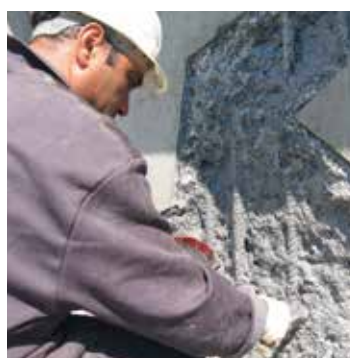
Principio 11 - método 11.1 Protección activa contra la corrosión de las armaduras MasterEmaco P 5000 AP
