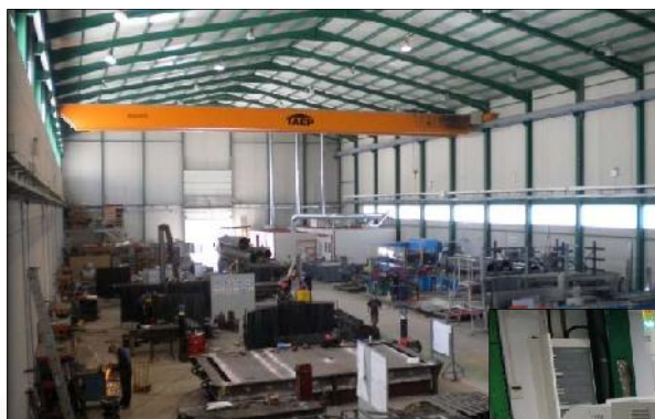
Talleres Mecánicos Cabina de pintura
