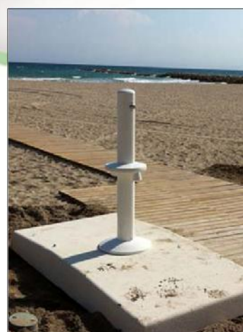
Instalación y puesta en marcha
