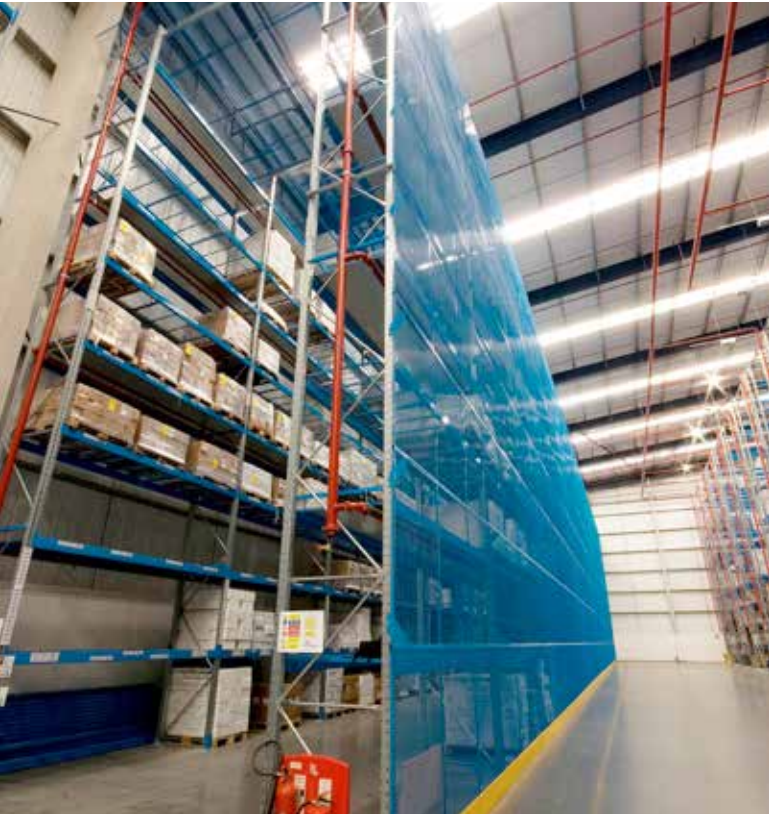
Paneles anti-caída Axelent SafeStore que se entregan con consolas especiales, con el color específico del cliente para que se adapten a la instalación existente.
