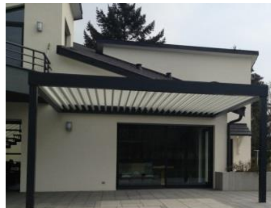
Instalación sobre fachada con 2 pilares
