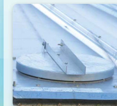
Puerta de inspección en techo Access roof door
