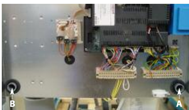
Canales de pasaje cables vistos desde el lado anterior de la caldera
