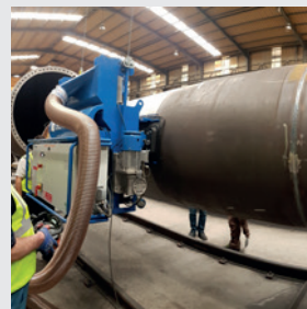
TURBINAS EÓLICAS Y TUBERÍAS DE ACERO
