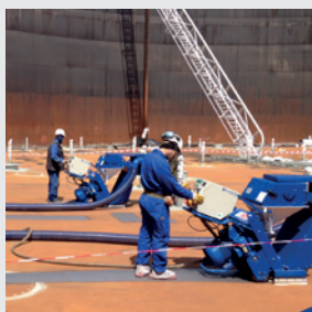
SUELOS Y TECHOS DE TANQUES
