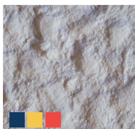
CSP-7 GRANALLADO PROFUNDO O FRESADO MEDIO
