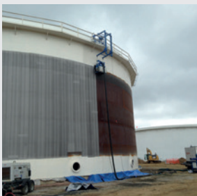
DEPÓSITO DE ALMACENAMIENTO
