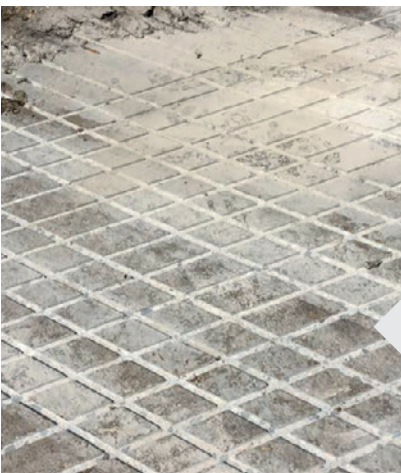
MULTICORTE CON UNA CONFIGURACIÓN ESPECIAL DEL TAMBOR
