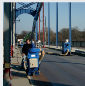
PUENTES DE ACERO Y CUBIERTAS DE ACERO
