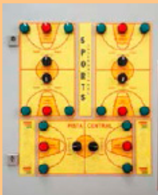
Cuadro de control de canatas motorizadas
